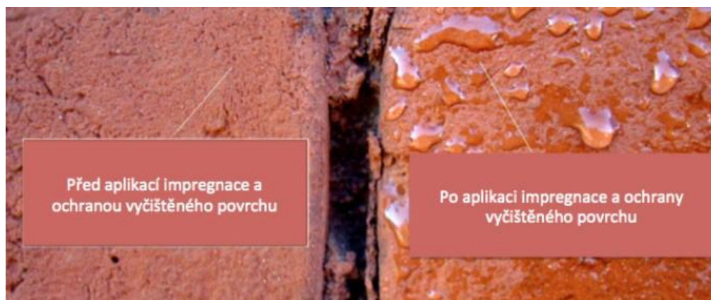
Obr. 32: Účinek hydrofobizace [43]
