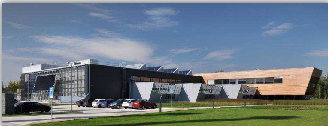
Obrázek 5: Budova UCEEB v katastru obce Buštěhrad
