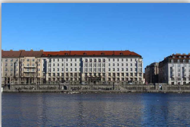
Obrázek 4: Budova ÚZSVM na Rašínově nábřeží
