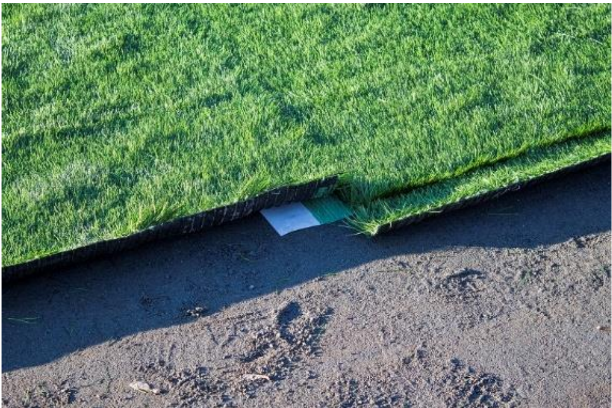
Obrázek 28 Podlepení spojovacími páskami [vlastní]
