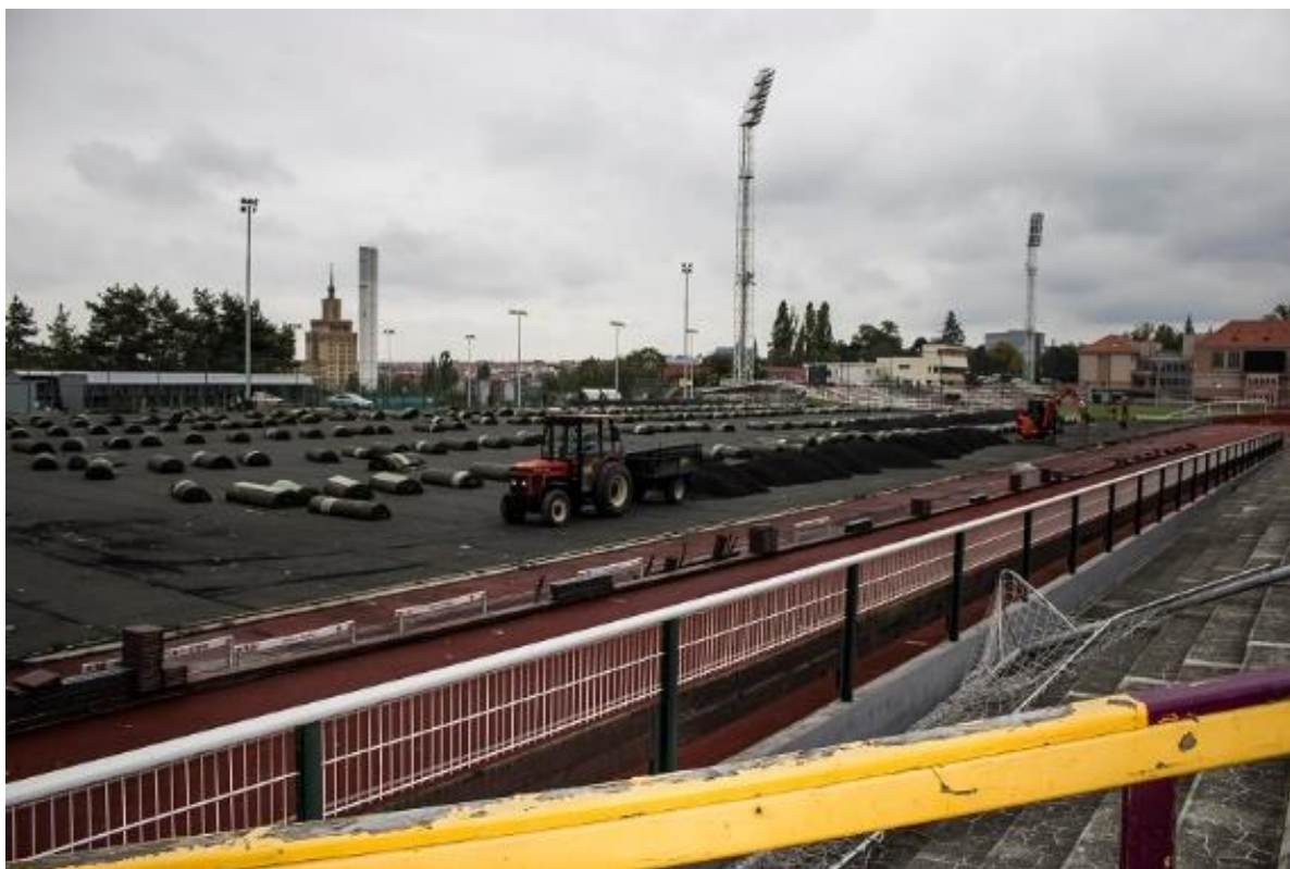
Obrázek 25 Průběh rekonstrukce, stržený povrch, bourání kanálu, dne 13. 10. 2016 [vlastní]
