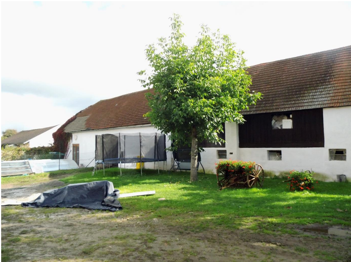
Obrázek 13: Fotografie, východní strana zemědělského objektu, zdroj: vlastní zpracování
