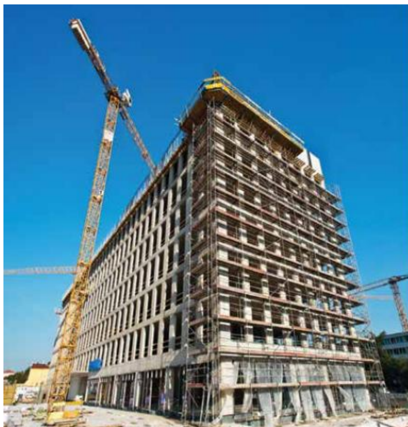
Obrázek 4.2: Výstavba monolitické konstrukce objektu A – foto z 9. září 2016
