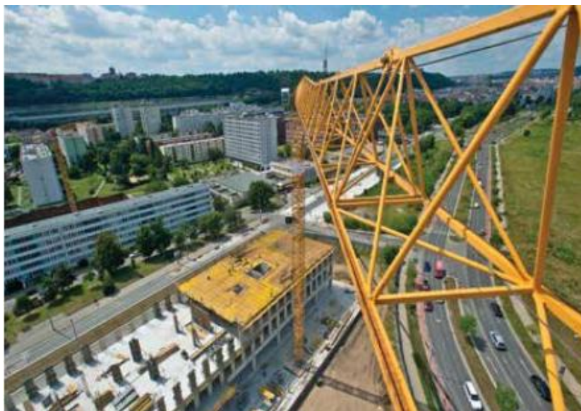
Obrázek 4.1: Výstavba monolitické konstrukce objektu A – foto ze 7. července 2016
