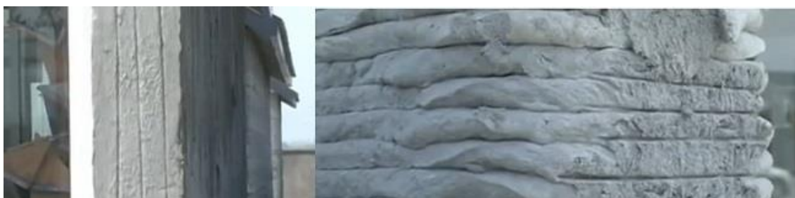
Obrázek 20: Detailní pohled na konstrukce vystavěné 3D tiskem
