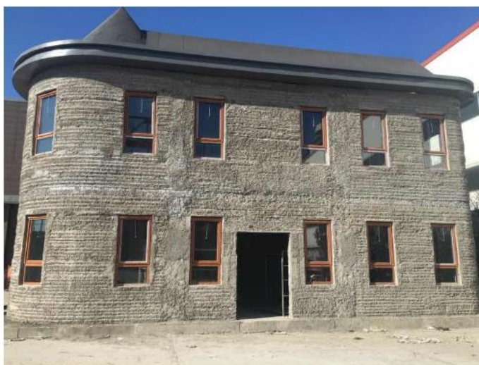
Obrázek 21: Vila vystavěna pomocí technologie 3D tisku firmou HuaShang Tenda
