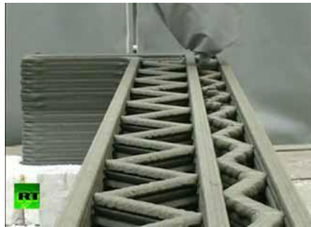
Obrázek 16: Lineární 3D tisk – Winsun, ČLR Zdroj: [27]
