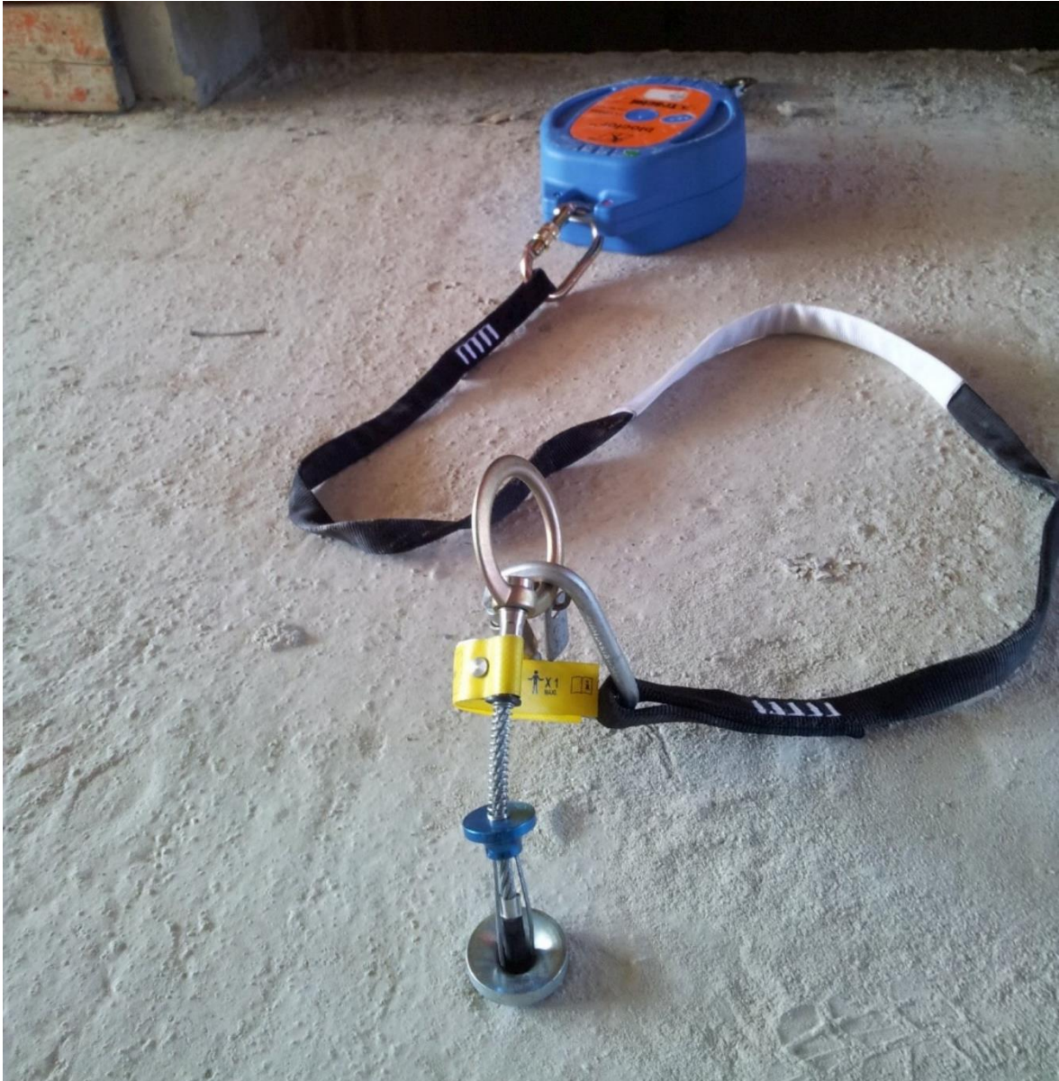
Obrázek 18: Mobilní kotevní bod pro monolitickou stropní konstrukci a zatahovací zachycovač pádu [archiv spol. Skanska a.s.]
