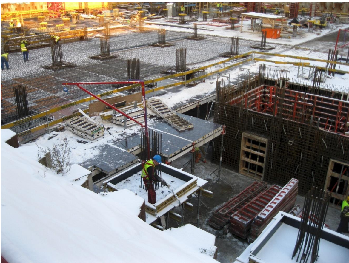
Obrázek 21: Ukázka systému Alsipercha v praxi [archiv spol. Skanska a.s.]
