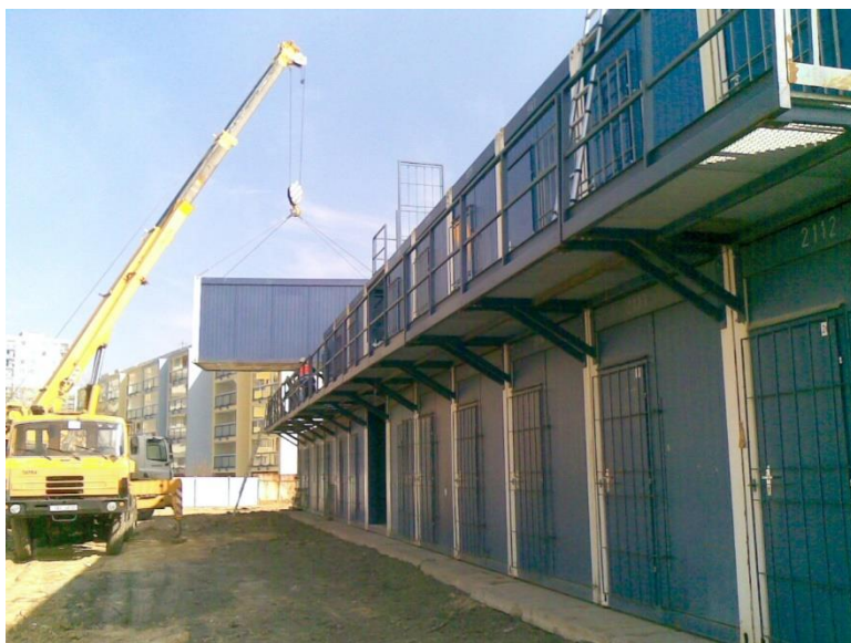
Obrázek 13: Dvoupodlažní buňkoviště s ochozem [archiv spol. Skanska a.s.]
