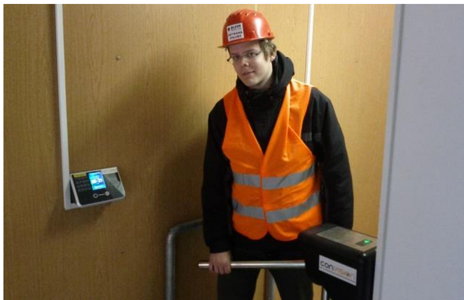
Obrázek 10: Třítyčový turniket s nutností ostrahy [ http://www.convision.cz/ ]
