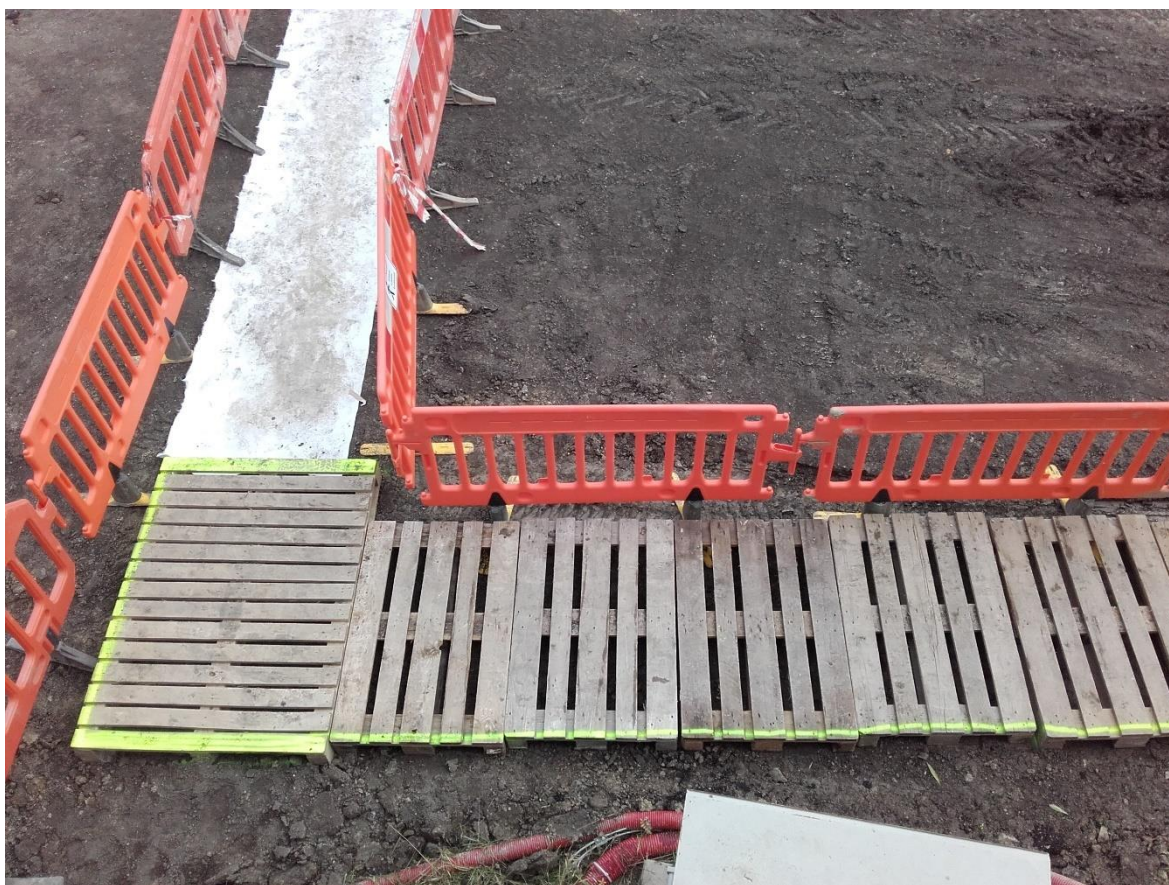
Obrázek 22: Plastové mobilní zábrany tvoří bariéru mezi pěším a dopravním koridorem [archiv autorky]
