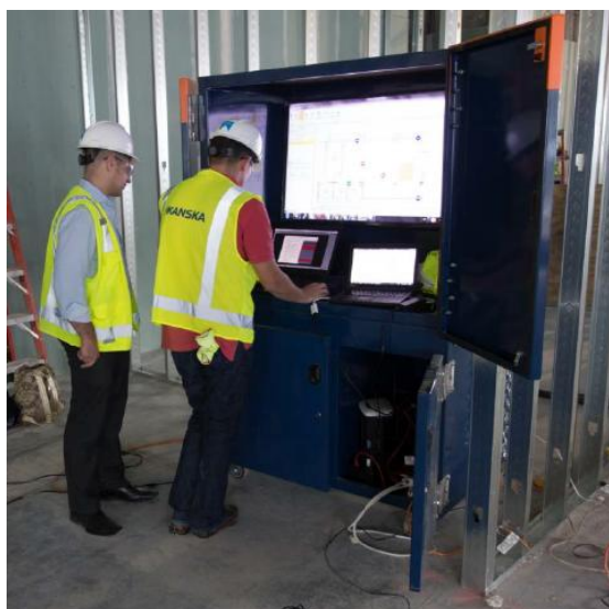
Obr. č. 78 Pracovníci používající BIM kiosek s RTLS, Zdroj [28]
