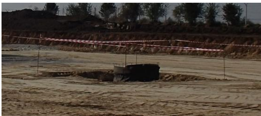
Obrázek 31 – Zabezpečení piloty ocelovými tyčemi s výstražnou páskou
