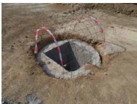
Obrázek 28 – Zakrytí otvoru výztuží s výstražnou páskou
