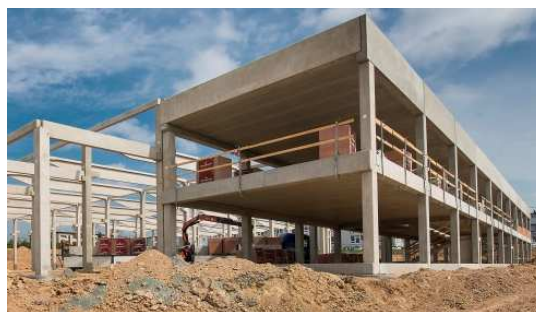
Obrázek 6: Dilatace objektů vlivem rozdílného sedání (7)
