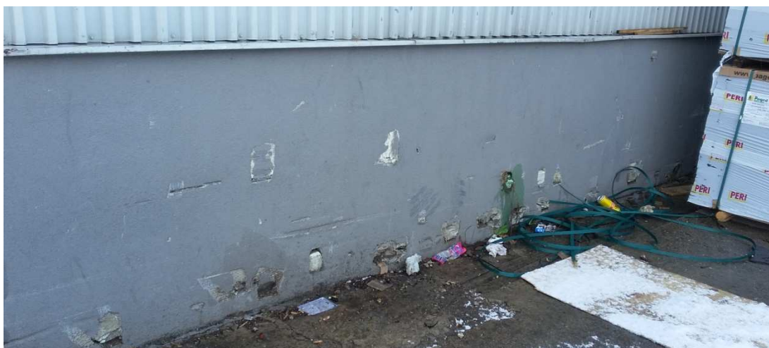
Obrázek 8: poškození zateplení vidlemi vysokozdvížného vozíku
