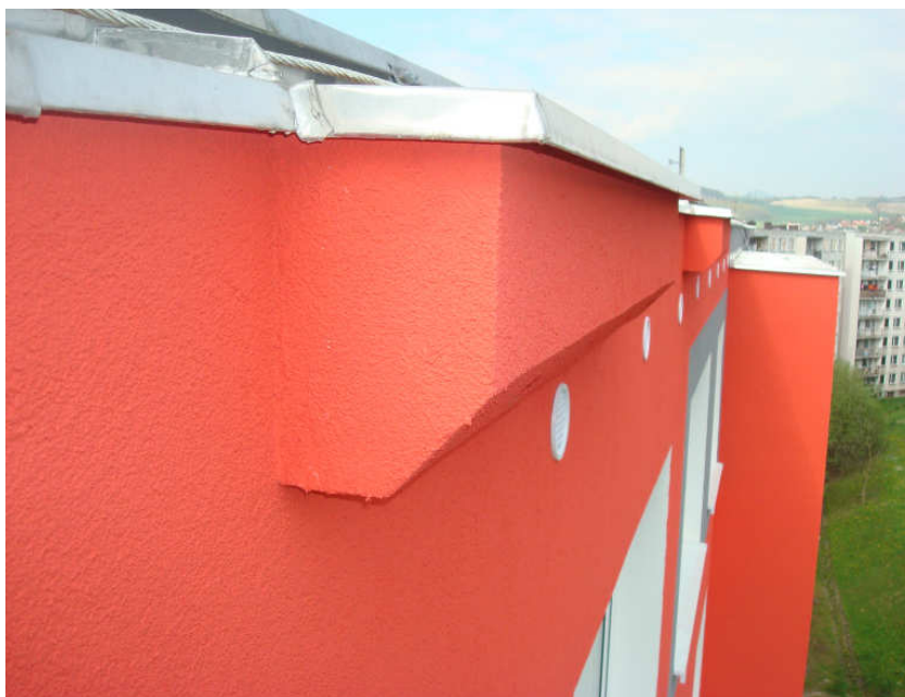
Obrázek 2.1-4: Umělá hnízdiště pro chráněné rorýsy rbecné
