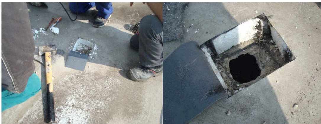
Obrázek 1.3-5: Detail tepelné izolace umístěné na horním plášti- střecha z in-situ měření v Litoměřicích
