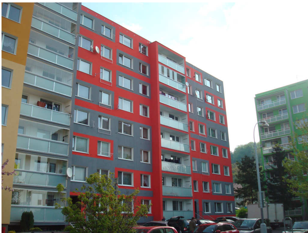
Obrázek 2.1-1: Objekt po rekonstrukci fasády
