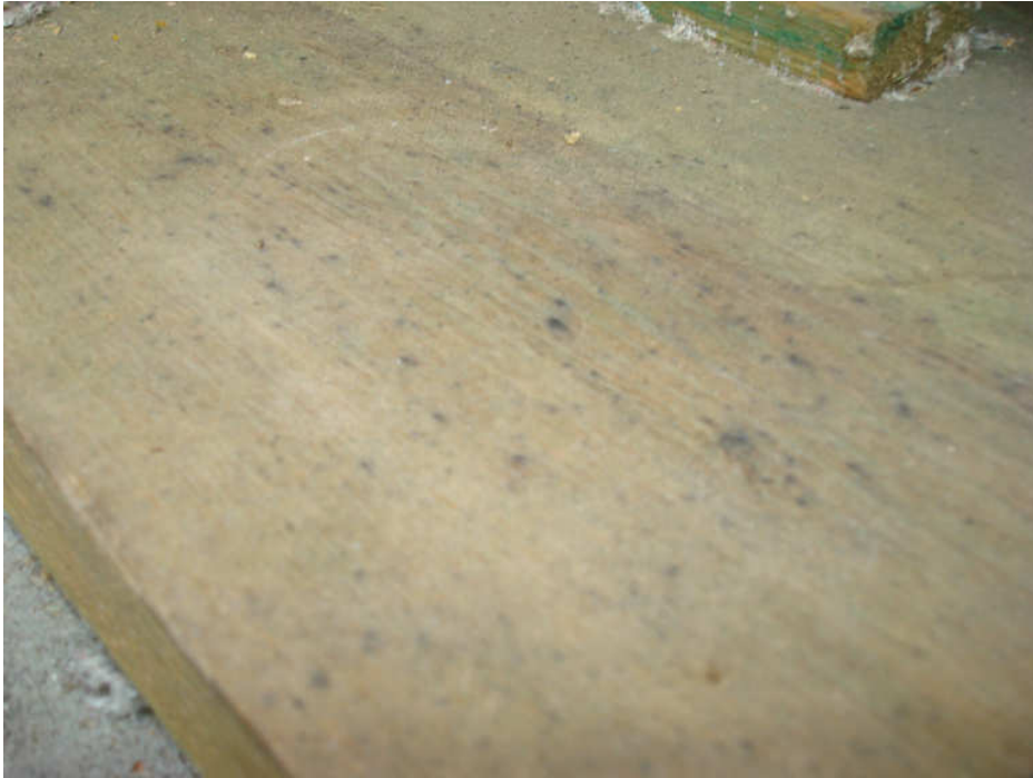
Obrázek 2.1-25: Detail podkladní fošny umístěné na pilíři u sondy č. 1
