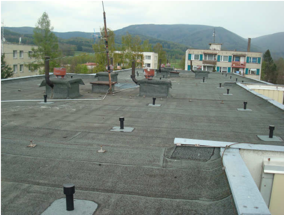
Obrázek 1.3-6: Viditelné rozmístění větracích komínků- střecha z in-situ měření Hejnice
