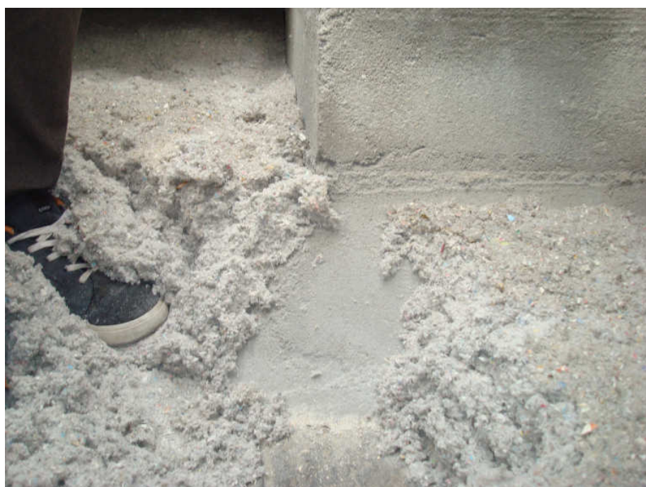
Obrázek 2.1-24: Detail paty pilíře u sondy č. 1
