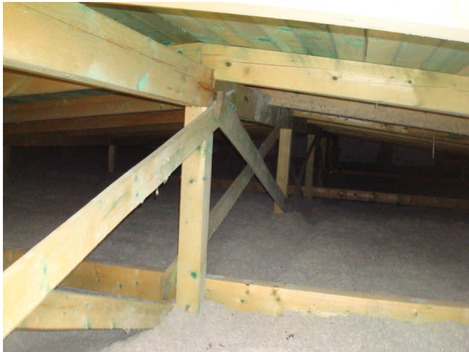
Obrázek 2.1-33: Dřevěná příhradová konstrukce
