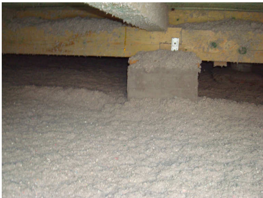
Obrázek 2.1-23: Prostor provětrávané dutiny u sondy č. 1 (u pilíře)
