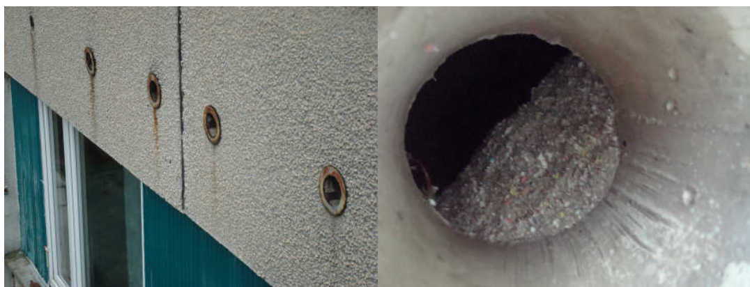
Obrázek 2.1-18: Pohled na atikové panely s větracími otvory a pohled na větrací otvor
