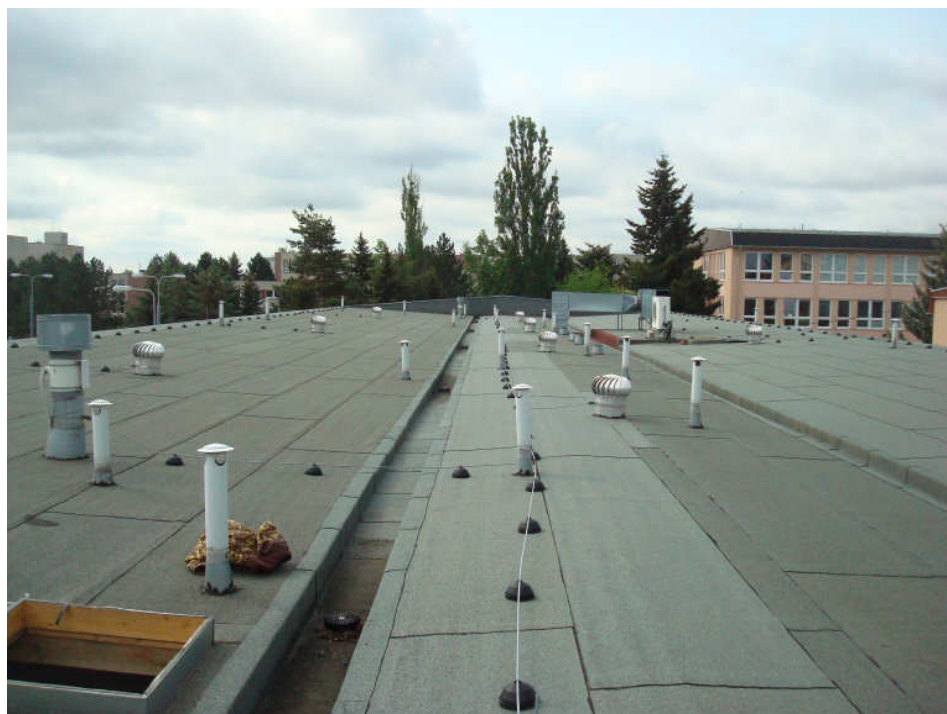
Obrázek 2.1-21: Pohled na střechu školní jídelny
