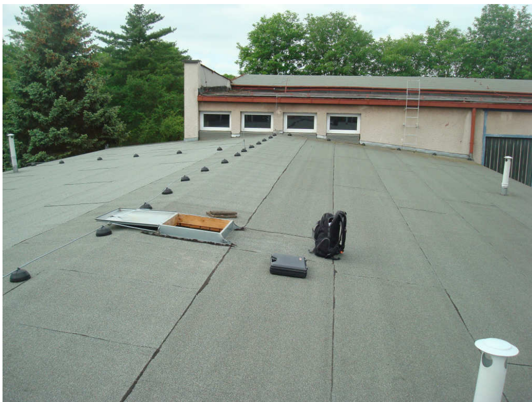
Obrázek 2.1-29: Pohled na střechu tělocvičny
