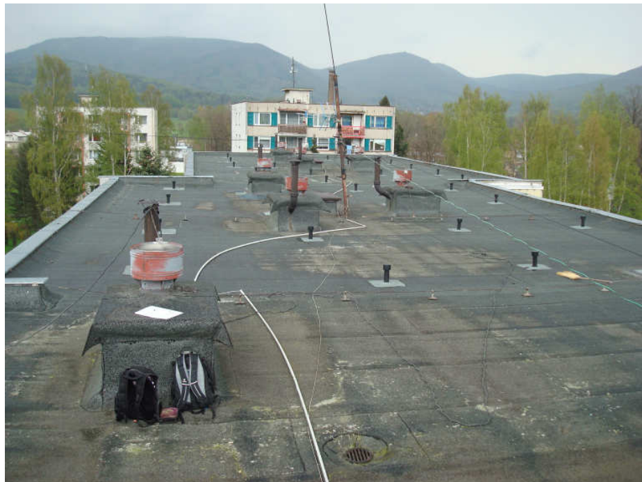
Obrázek 2.1-11: Pohled na střechu
