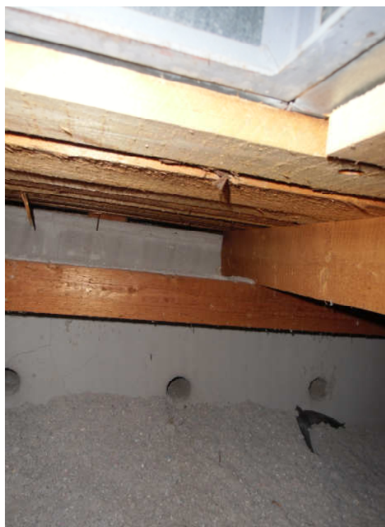
Obrázek 3.5-2: Detail uložení vaznice na atikový panel [4]
