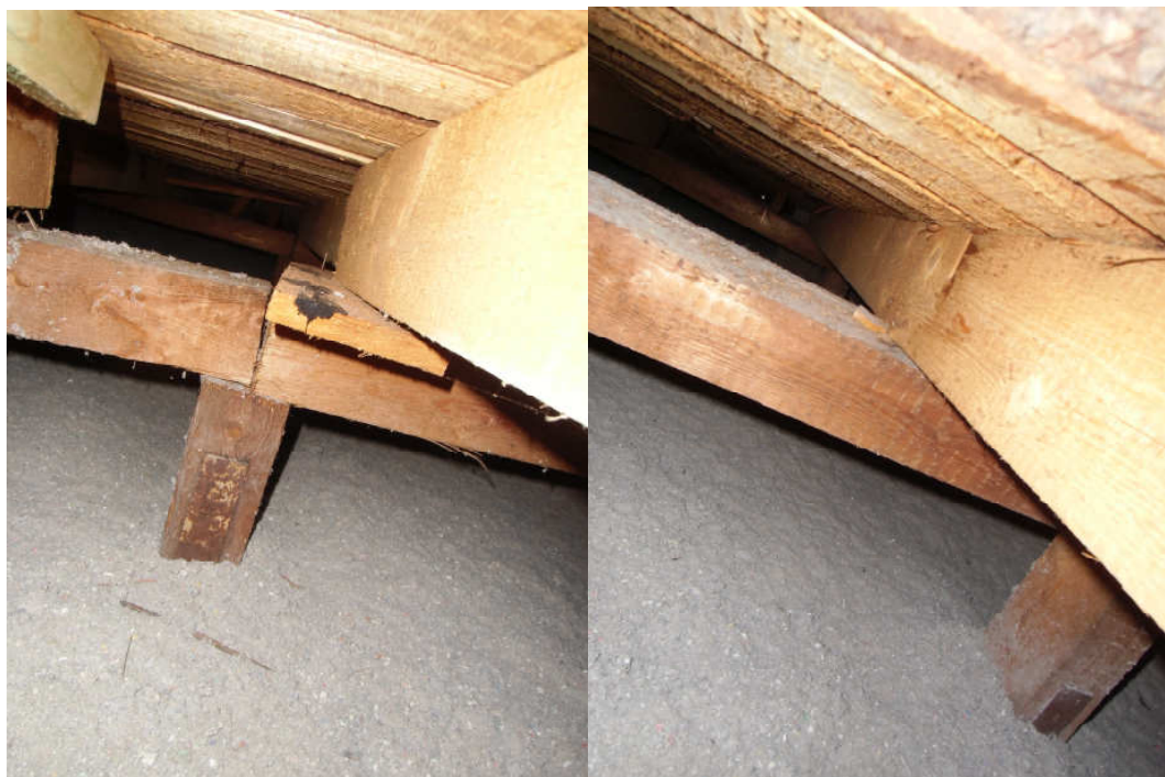
Obrázek 3.5-1: Detail uložení vaznic na sloupky [4]
