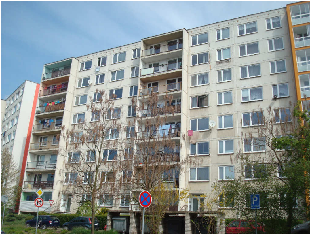
Obrázek 1.2-1: Panelový objekt typu VVÚ-ETA s viditelnými větracími otvory v oblasti atikových panelů
