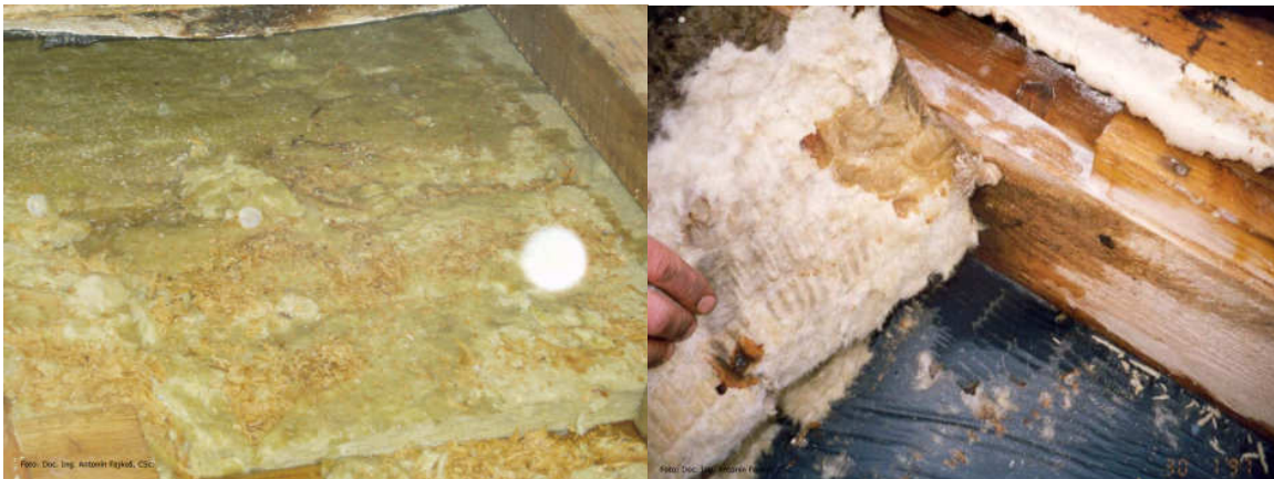
Obrázek 1.3-3: Vlhké materiály a první stopy růstu plísní a hub [22]
