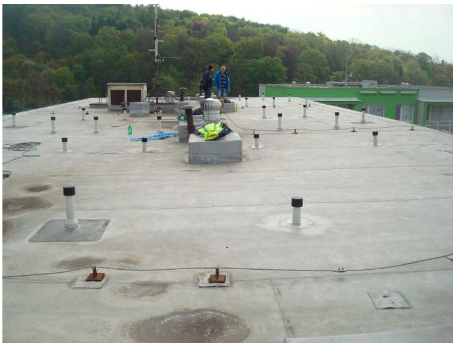
Obrázek 2.1-2: Pohled na střechu
