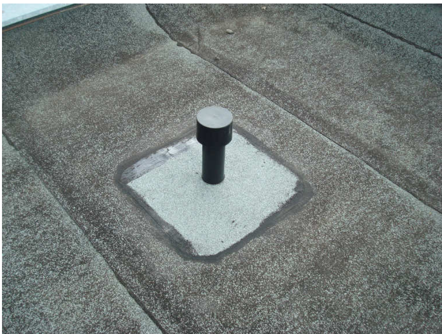
Obrázek 2.1-13: Odvětrávací komínek výšky 260mm
