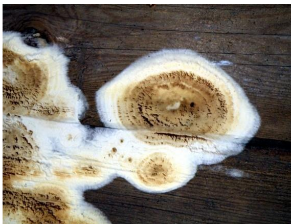
Obrázek 10: Rozrostlá plodnice koniofory sklepní (6).
