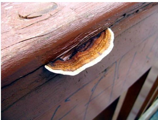
Obrázek 12: Plodnice trávovky na dřevěném prvku (8).
