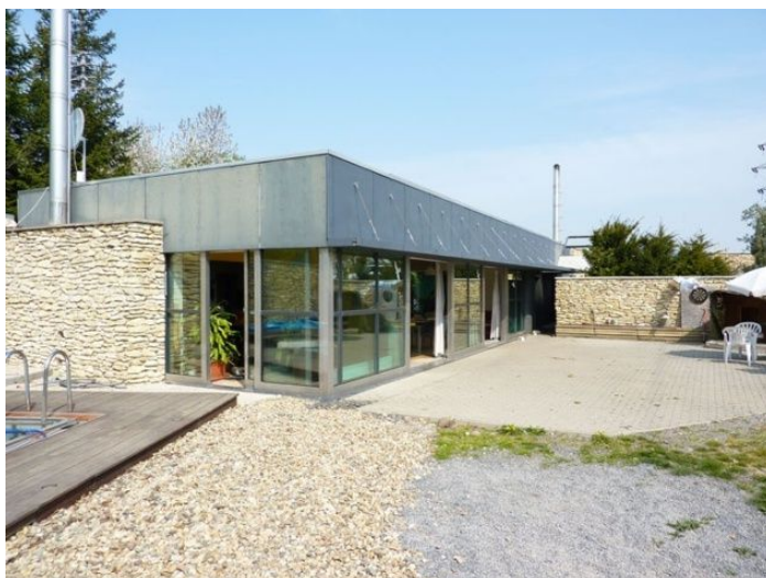
Obrázek 9 - Jižní prosklená část - vstup do obývacího pokoje (2)
