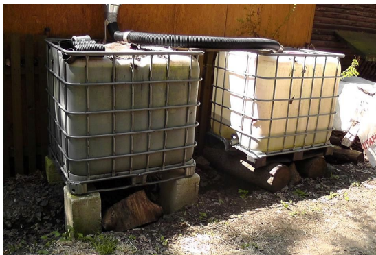
Obrázek 3 - Nádrže na dešťovou vodu (1)
