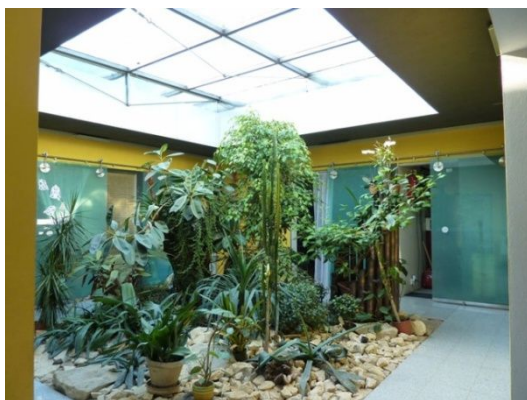
Obrázek 8 - Atrium domu - jediné osvětlení vnitřních pokojů (2)
