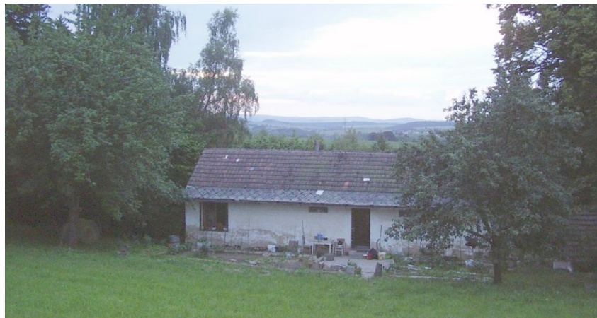
Obrázek 16 - Stav domu před rekonstrukcí (6)
