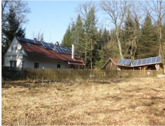
Obrázek 2 - Pohled na obě budovy Nezávislého domu (1)
