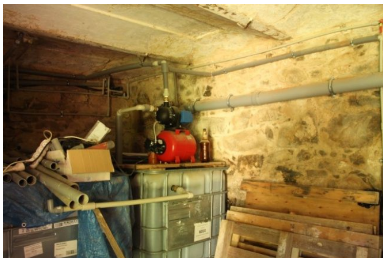
Obrázek 20 - Domácí vodárna a nádrž na dešťovou vodu (autor)
