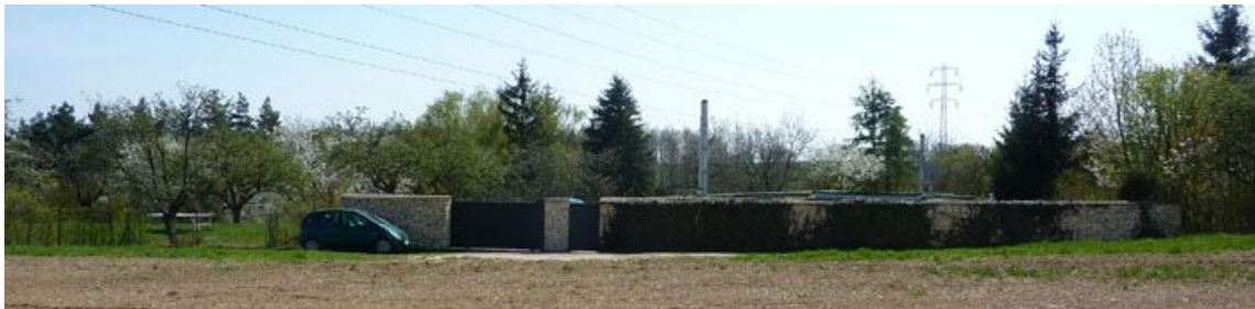
Obrázek 6 - Pohled na dům z ulice (2)
