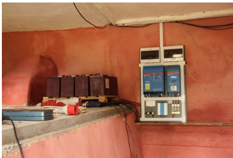
Obrázek 23 - Baterie a měnič pro ostrovní systém (autor)
