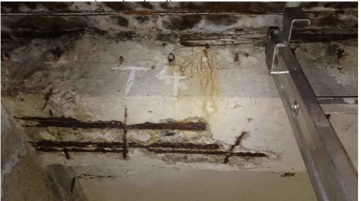
Obr.12 Pohled na sondu T4 (trám u výtahový šachty)
