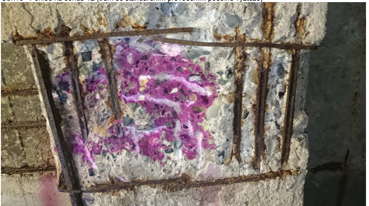
Obr.10 Pohled na sondu T2 (trám se standardním provedením podélné výztuže)
