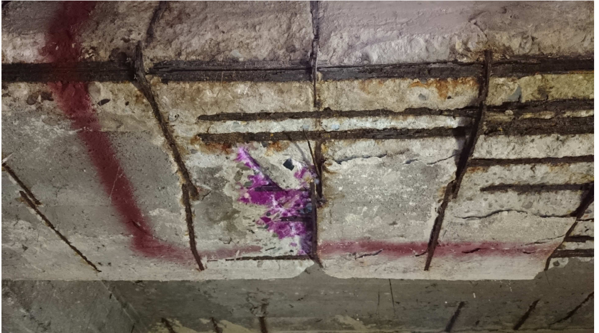
Obr.9 Pohled na sondu T1
