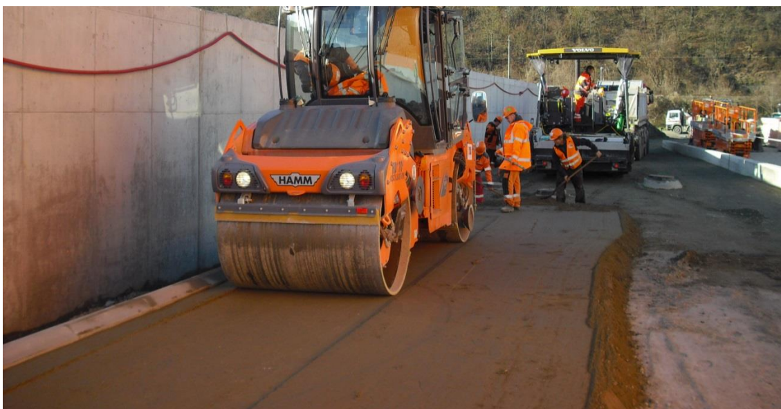
Obrázek 2-3 Válcování tandemovým válcem ve statickém pojezdu
