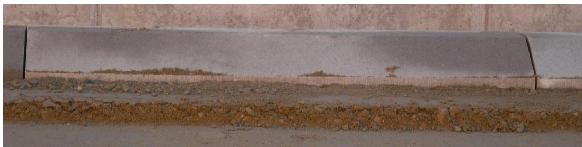
Obrázek 2-6 Nezhutněná vrstva u kraje betonového obrubníku
