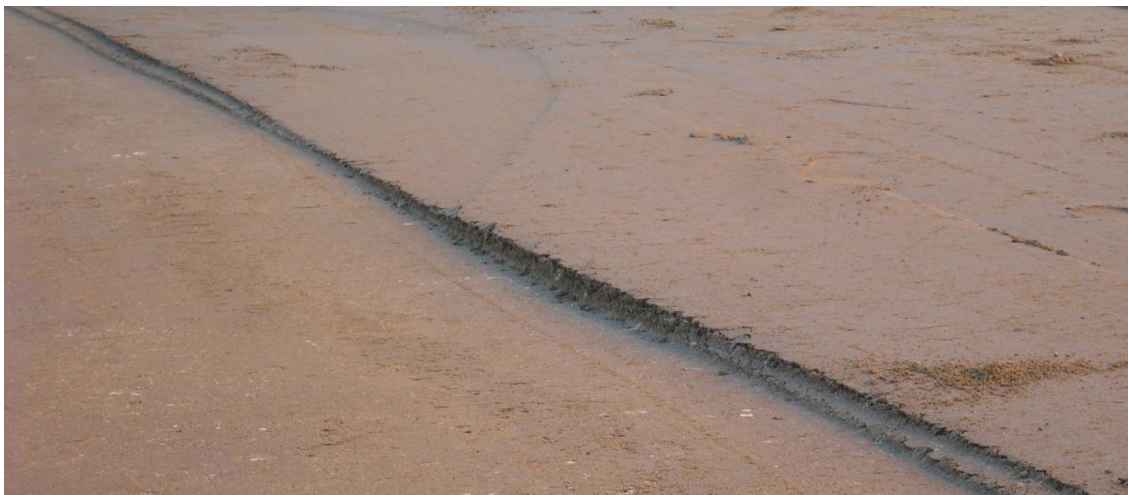
Obrázek 2-4 Hrana hutněné a nehutněné vrstvy
