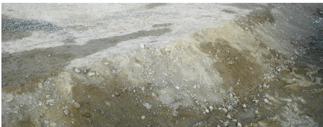
Obrázek 2-7 Konečná krajnice ve směru pokládky musí být zaříznuta a odstraněna
