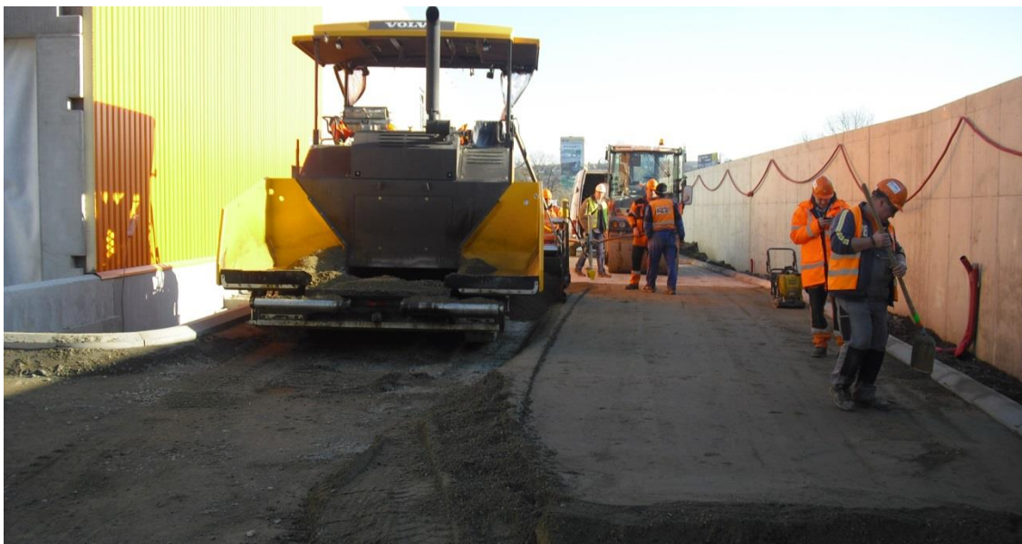
Obrázek 2-5 Pokládka sousední vrstvy válcovaného betonu
