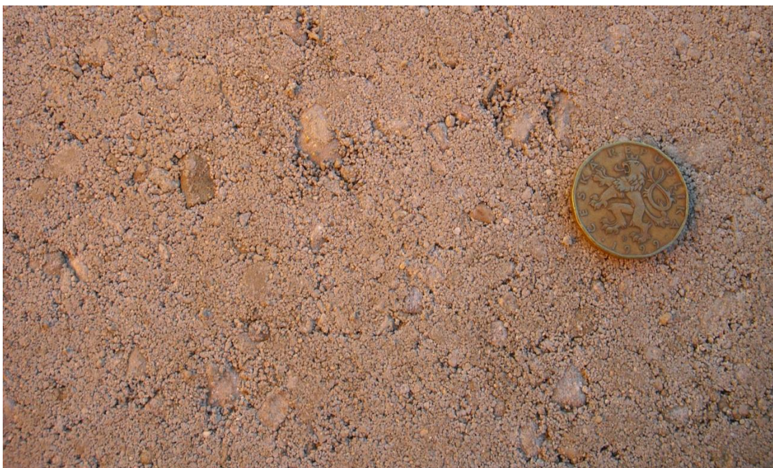
Obrázek 2-2 Povrch válcovaného betonu po pokládce
