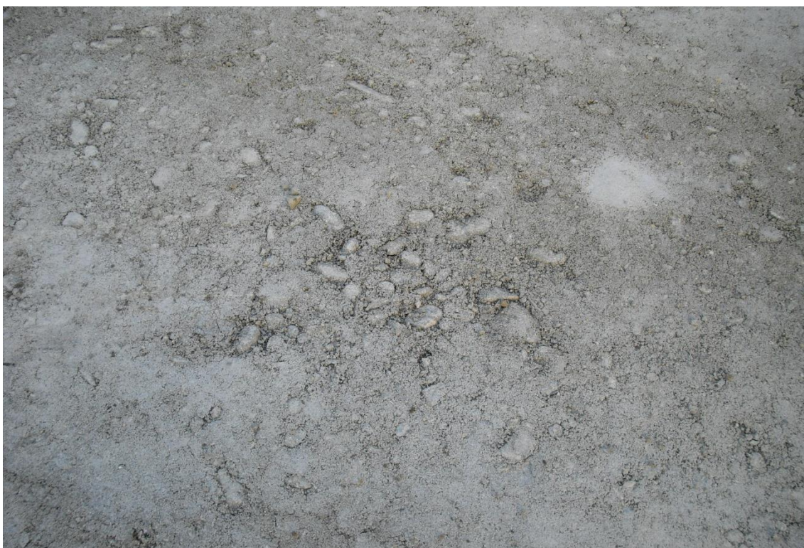
Obrázek 2-8 Povrch válcovaného betonu 7 dní od pokládky
