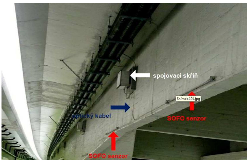
Obr. 27 Příklad umístění senzorů na konkrétní konstrukci [25]
