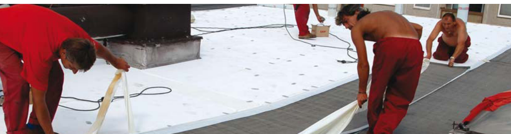
02 skladba dvouplášťové střechy s pojistnou hydroizolací
