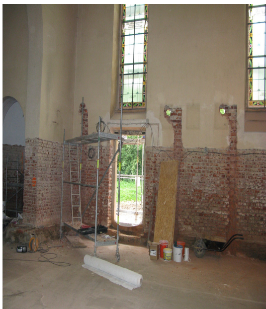
Foto 19 : Kostel sv. Bonifáce – provedení odváděcího potrubí (autor: Ing. Jiří Novotný)
