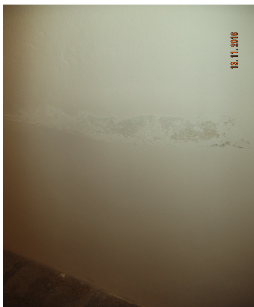
Foto 26: Kostel sv. Antonína Velikého – projev vlhkosti na stěně, na hraně sanační omítky (autor: Martina Sehořová)
