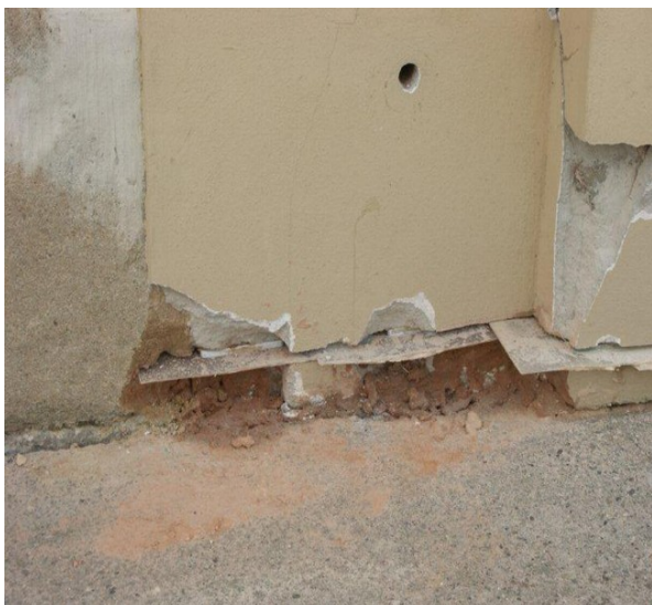
Foto 23: Kostel sv. Josefa– provedení podřezání objektu (autor: [39])
