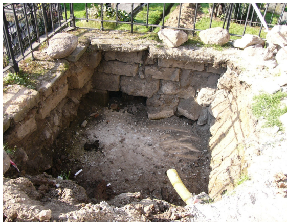
Foto 15: Kostel sv. Umučení sv. Jana Křtitele – výkop pro vsakovací studni (autor: Ing. Jiří Novotný)
