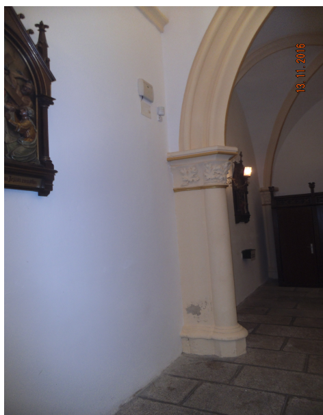
Foto 26: Kostel sv. Antonína Velikého – projev vlhkosti na stěně, na hraně sanační omítky (autor: Martina Sehořová)
