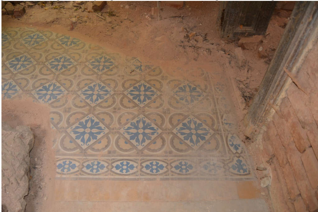
Obrázek 15 - Dochovaná původní dlažba
