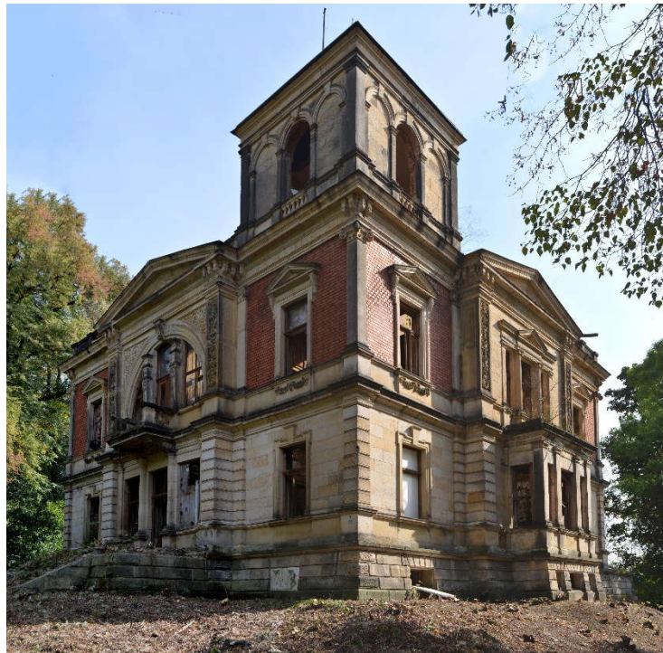
Obrázek 17 - Pohled na severozápadní a jihozápadní fasádu
