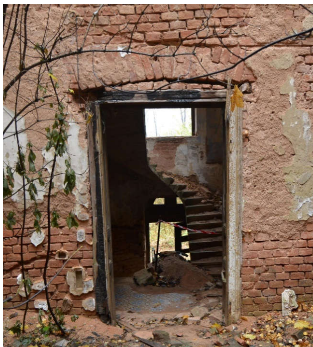
Obrázek 10- Pohled na klenuté nadpraží otvoru
