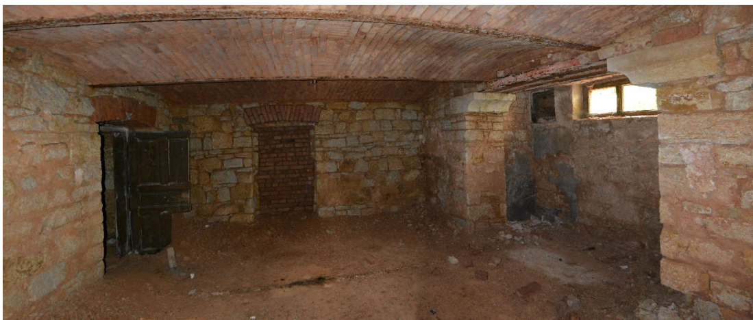
Obrázek 5 - Kamenné zdivo v podzemním podlaží
