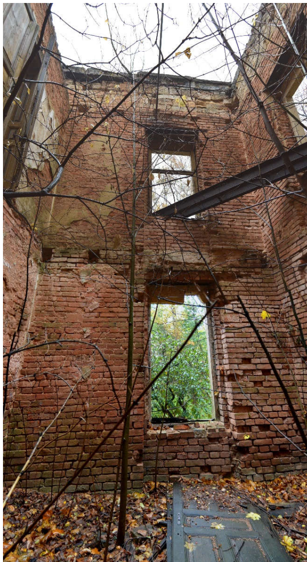
Obrázek 6 - Degradující zdivo
