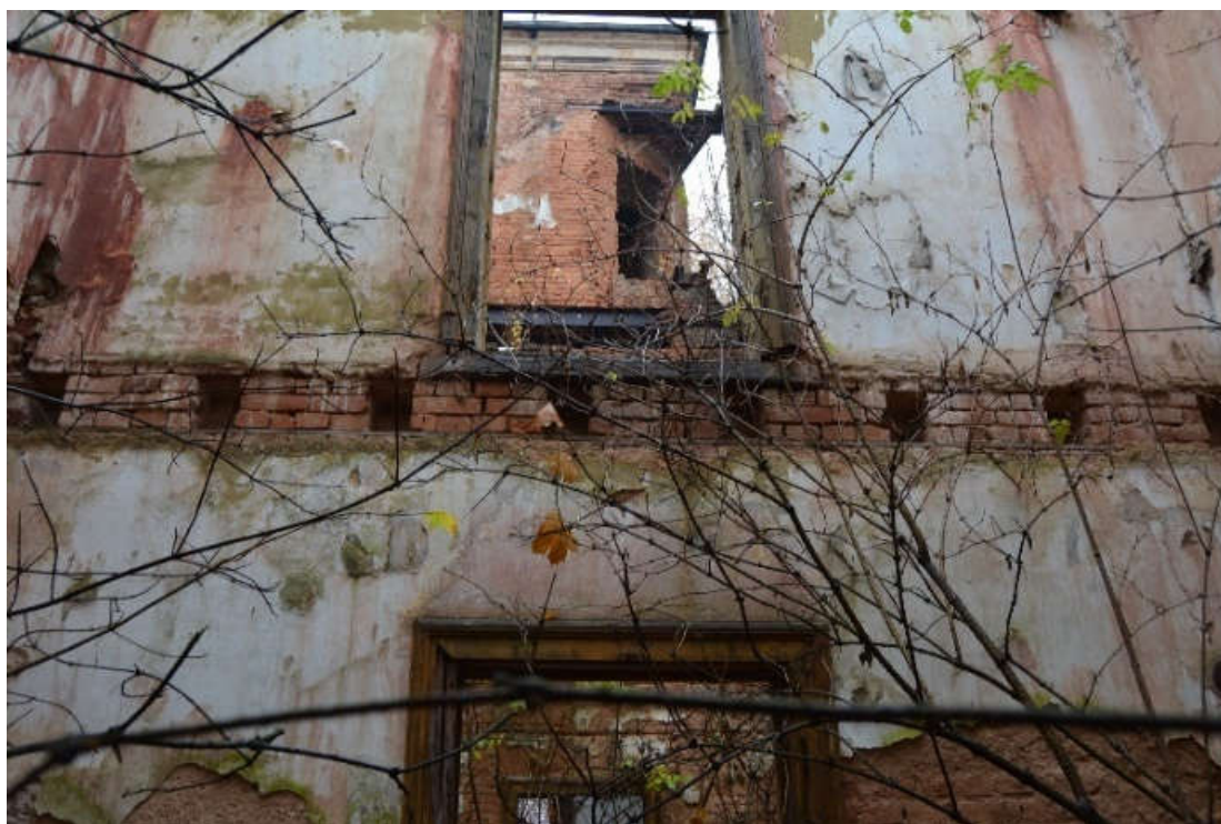
Obrázek 9 - Dochované kapsy po dřevěných stropních trámech
