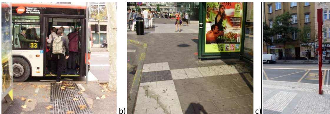
a) Signální pás navádějící nevidomého do prvních dveří autobus a) v Barceloně, b) ve Stockholmu, c) signální pás k značnicku zastávky a do prvních dveří tramvaje v Praze
