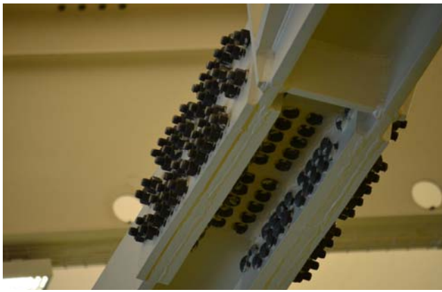
Obrázek 113 Šroubovaný spoj vazníků pro následnou snadnou demontáž
