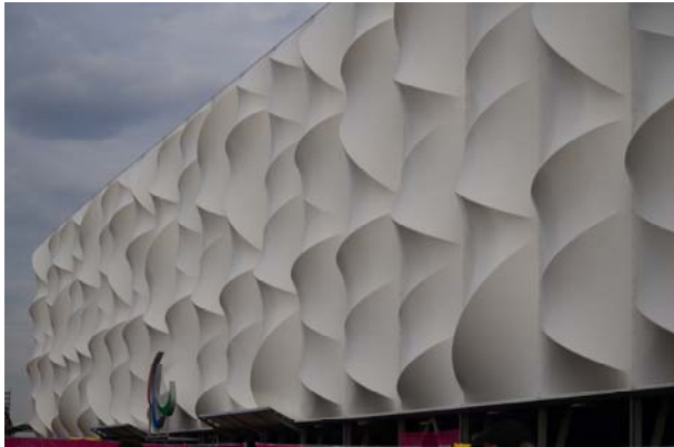
Obrázek 120 Membránová konstrukce obvodového pláště londýnské basketbalové haly
