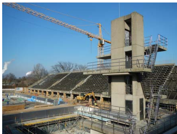
Obrázek 46 Olympijský plavecký bazén v Berlíně – současný stav
