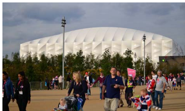
Obrázek 119 Londýnská basketbalová hala
