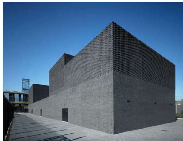
Obrázek 103 Transformační stanice v Londýně
