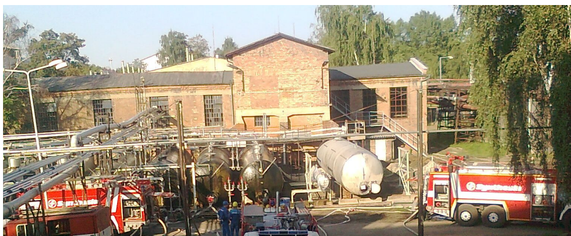
Obrázek 4: Úložiště odpadních nitráčních směsí
