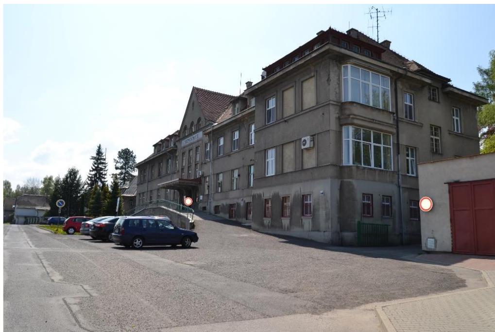
Obrázek 5-20 Budova Lužické nemocnice a.s. v roce 2016 (LUŽICKÁ NEMOCNICE a POLIKLINIKA, a.s. 2016)
