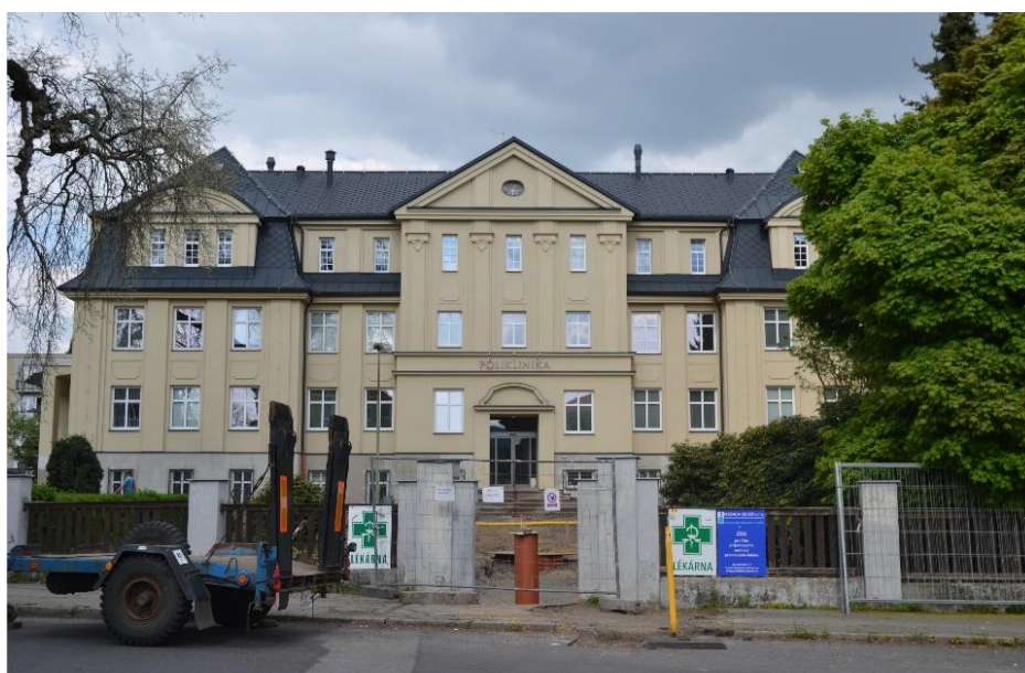
Obrázek 5-24 Budova Polikliniky v roce 2016 (NEMOCNICE VARNSDORF, příspěvková organizace 2016)
