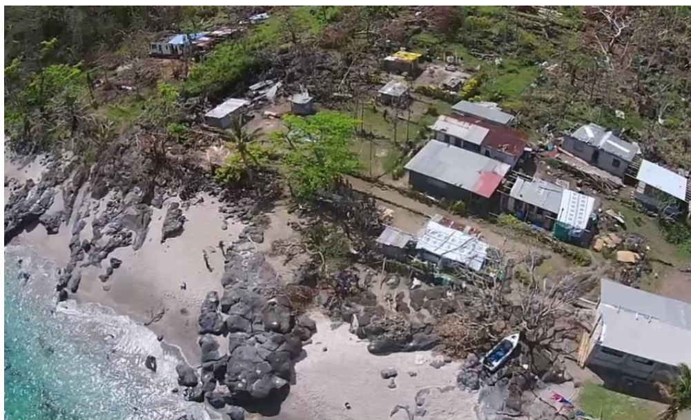
Obrázek 10 - Záběr poškozeného pobřeží, pořízený z UAV
