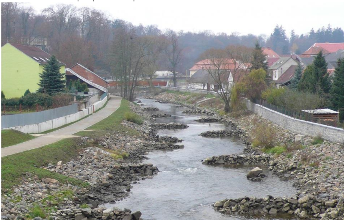
Obrázek 2: Realizovaná protipovodňová opatření
