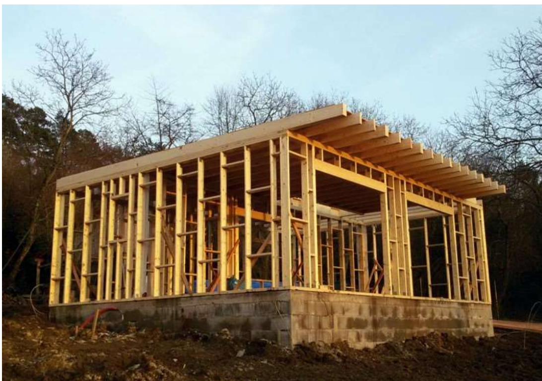
Obr. 1: Příklad realizace systémem Two by Four [Vytvořeno autorem]
