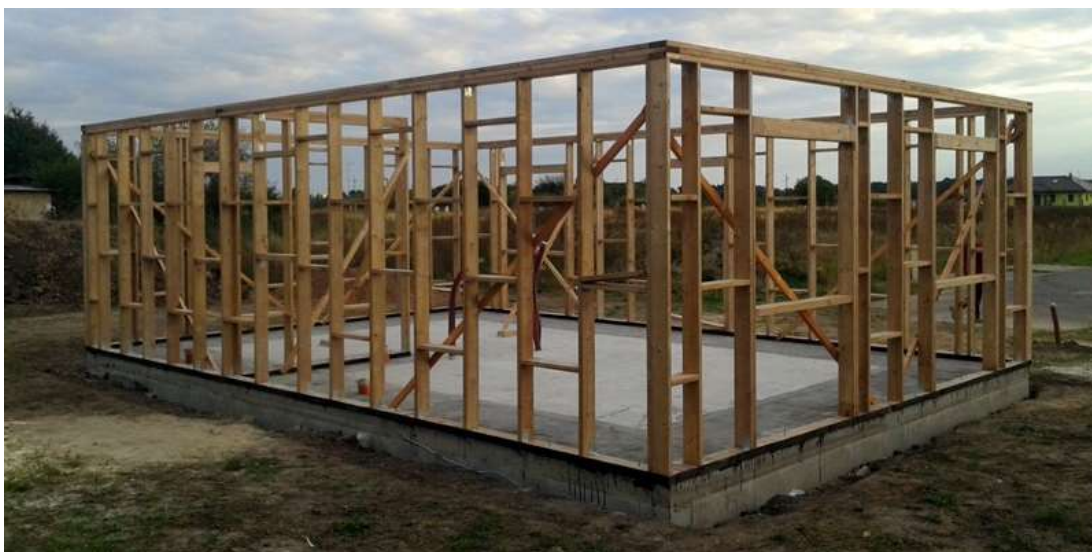
Obr. 14: Příklad provedení nosné konstrukce 1.NP [Vytvořeno autorem]
