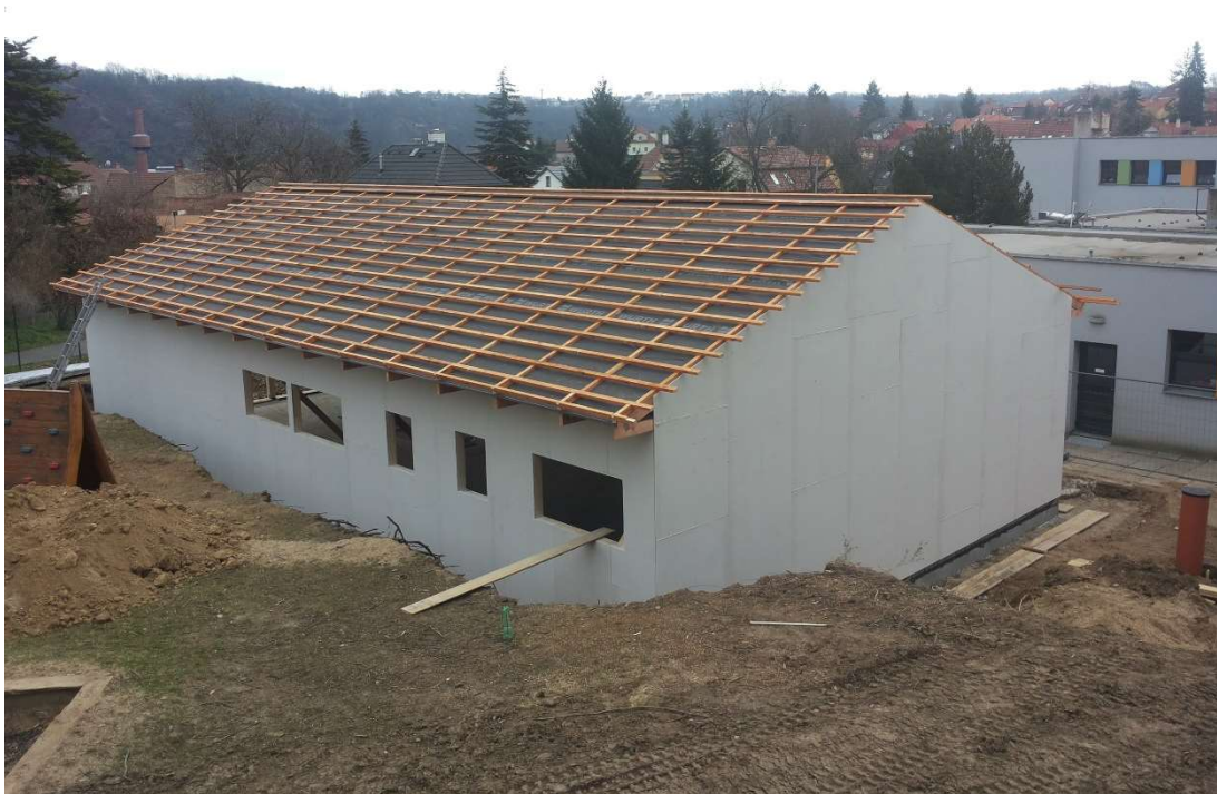
Obr. 18: Provedení střešního pláště – laťování [Vytvořeno autorem]
