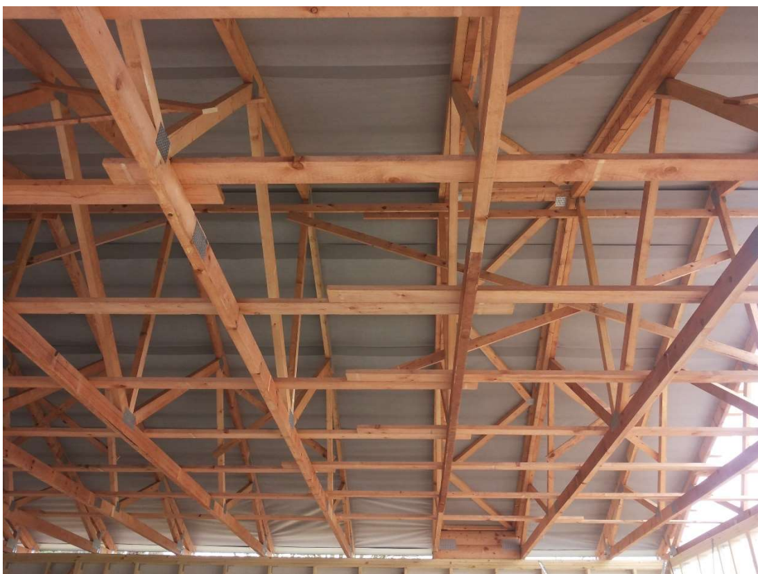
Obr. 17: Nosná konstrukce střechy z příhradových vazníků [Vytvořeno autorem]
