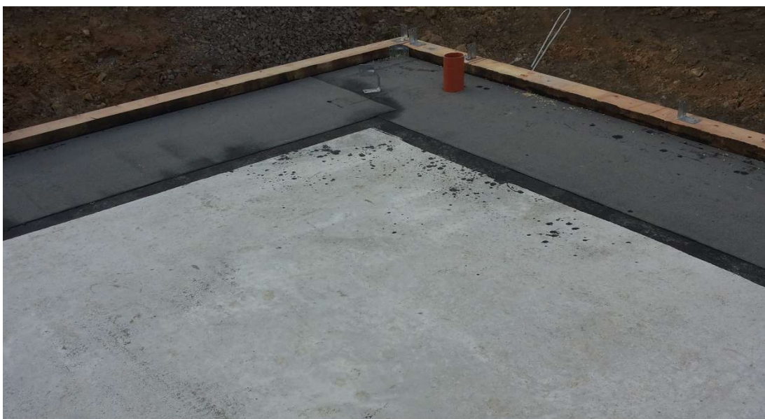
Obr. 12: Osazení zakládacích prahů na podkladní betonovou konstrukci [Vytvořeno autorem]
