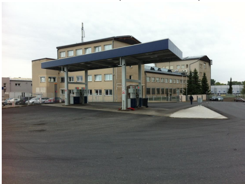
Obrázek 4 – Vlastní čerpací stanice v areálu firmy
