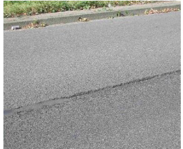
Obrázek 9: Ztráta hmoty - hloubková koroze na podélné spáře [38]
