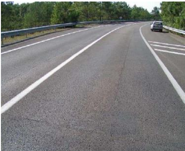
Obrázek 10: Nekvalitně provedená příčná spára [39]
