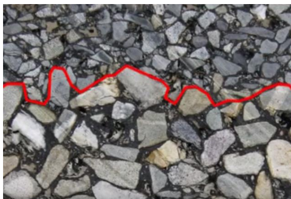
Obrázek 1: Detail spojení obrusné a ložní vrstvy [4]
