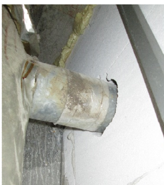
Obr. 16 Napojení vodorovné odbočky \varnothing 100 do odvodní šachty
