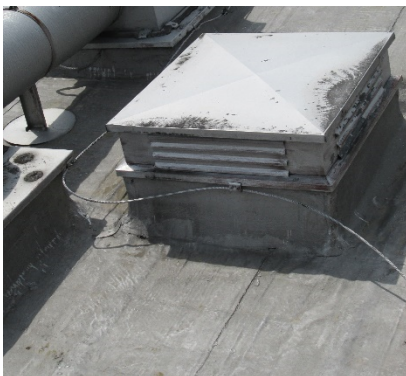
Obr. 14 Krycí stříška přívodní šachty
