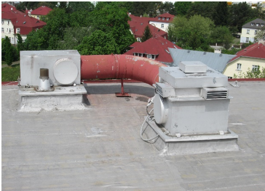
Obr. 12 Vlevo sběrná komora a odvětrání kanalizace, vpravo ventilátor NRC 8-1 připojený potrubím \varnothing 405
