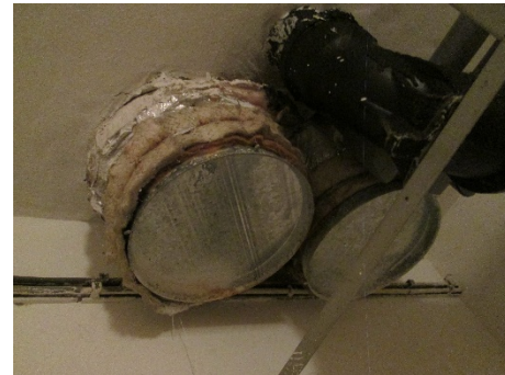
Obr. 13 Zakončení dvojice odvodních stoupaček \varnothing 300 v nejnižším podlaží
