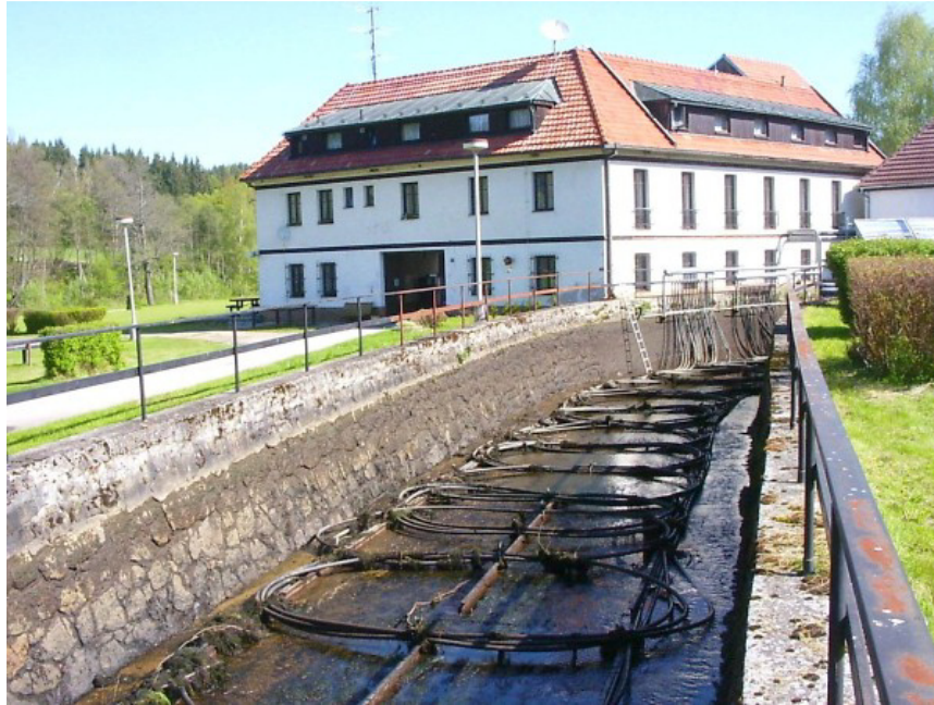
Obr. 6-5 Výměník v náhonu Herbertov [41]
