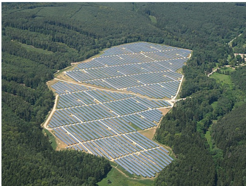
Obr. 2-5 Fotovoltaická elektrárna Ralsko Ra 1 [17]
