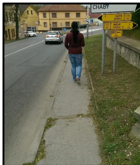
Obrázek 51 Nedostačující šířka chodníkové plochy (ulice Smíchovská)
