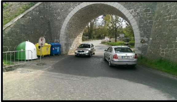
Obrázek 78 Umístění komunálních kontejnerů tříděného odpadu (ulice Dalejská) 1a
