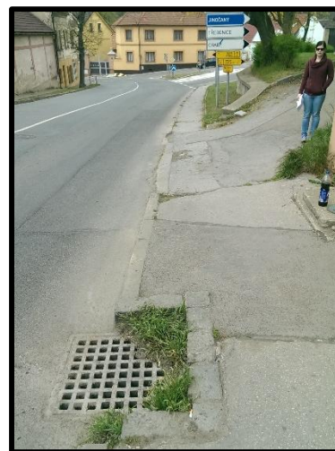
Obrázek 49 Špatně situovaná kanalizační vpust' (ulice Smíchovská)
