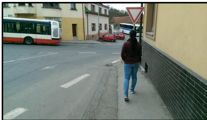
Obrázek 60 Nedostatečná šíře chodníkové plochy v prostoru severní křižovatky
