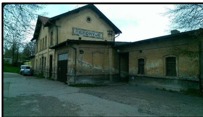
Obrázek 4 Železniční stanice MČ Praha-Řeporyje 1a
