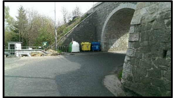
Obrázek 79 Umístění komunálních kontejnerů tříděného odpadu (ulice Dalejská) 1b
