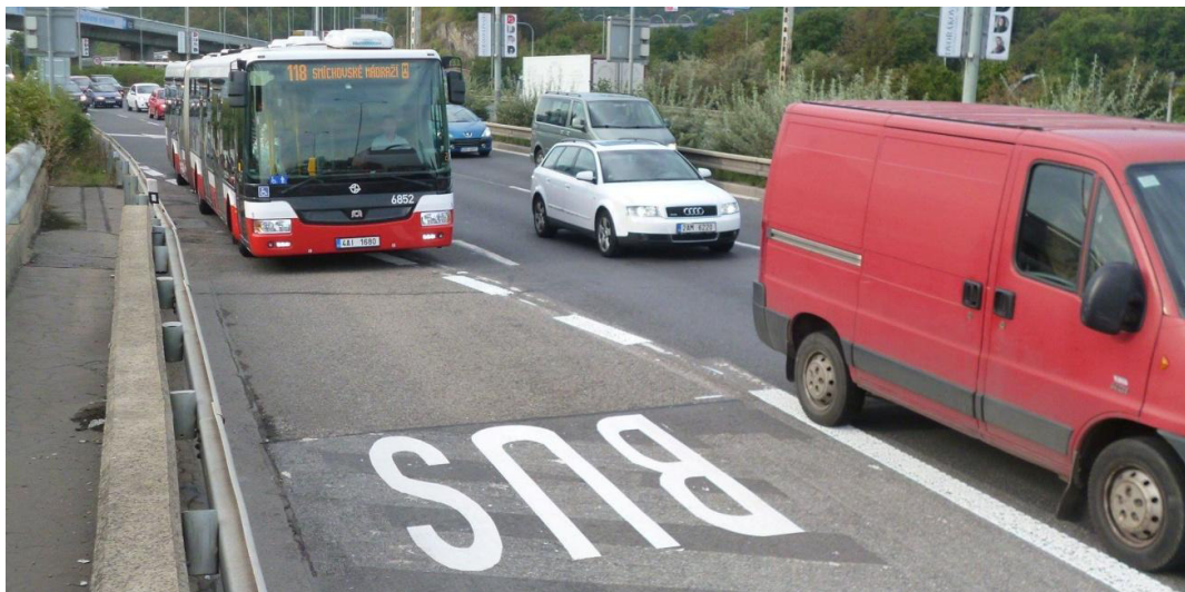
(Obr. 33 - Zřízení VJP v místě dopravního stínu, zdroj: ROPID, DIPRO)
