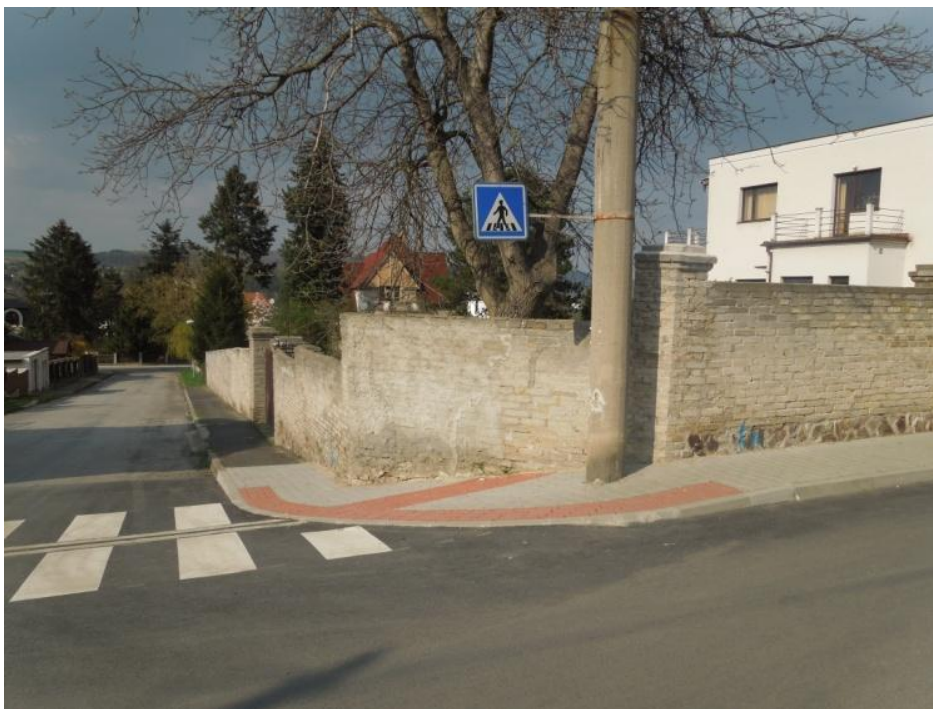
Obrázek 29 - nevhodně řešený přechod pro chodce v ulici Mařákova
