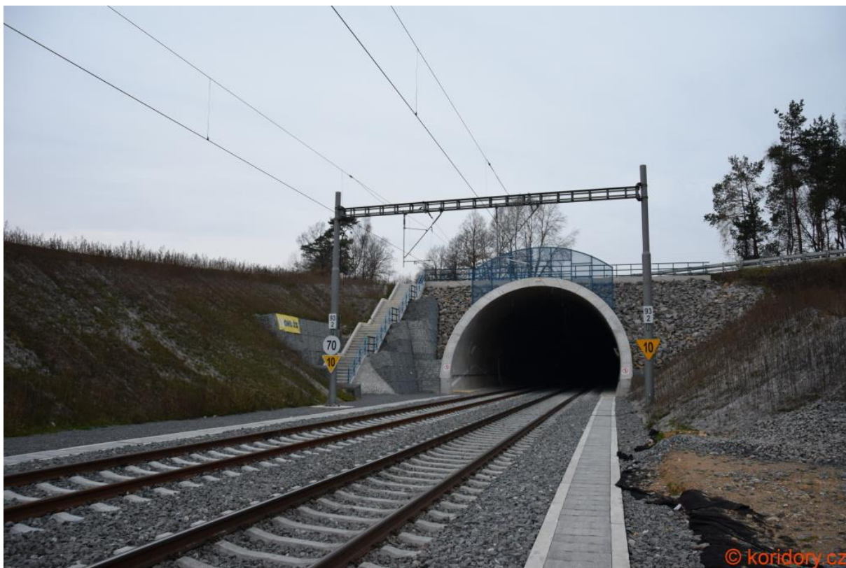
Obrázek 14: Součástí přeložky v úseku Chotoviny - Sudoměřice u Tábora je i dvoukolejný tunel [5]
