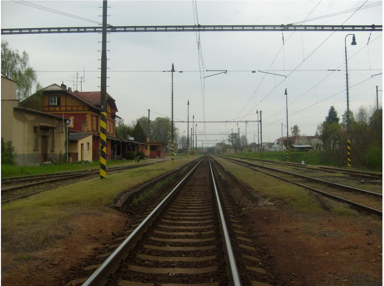
Obrázek 5: Železniční stanice Kardašova Řečice
