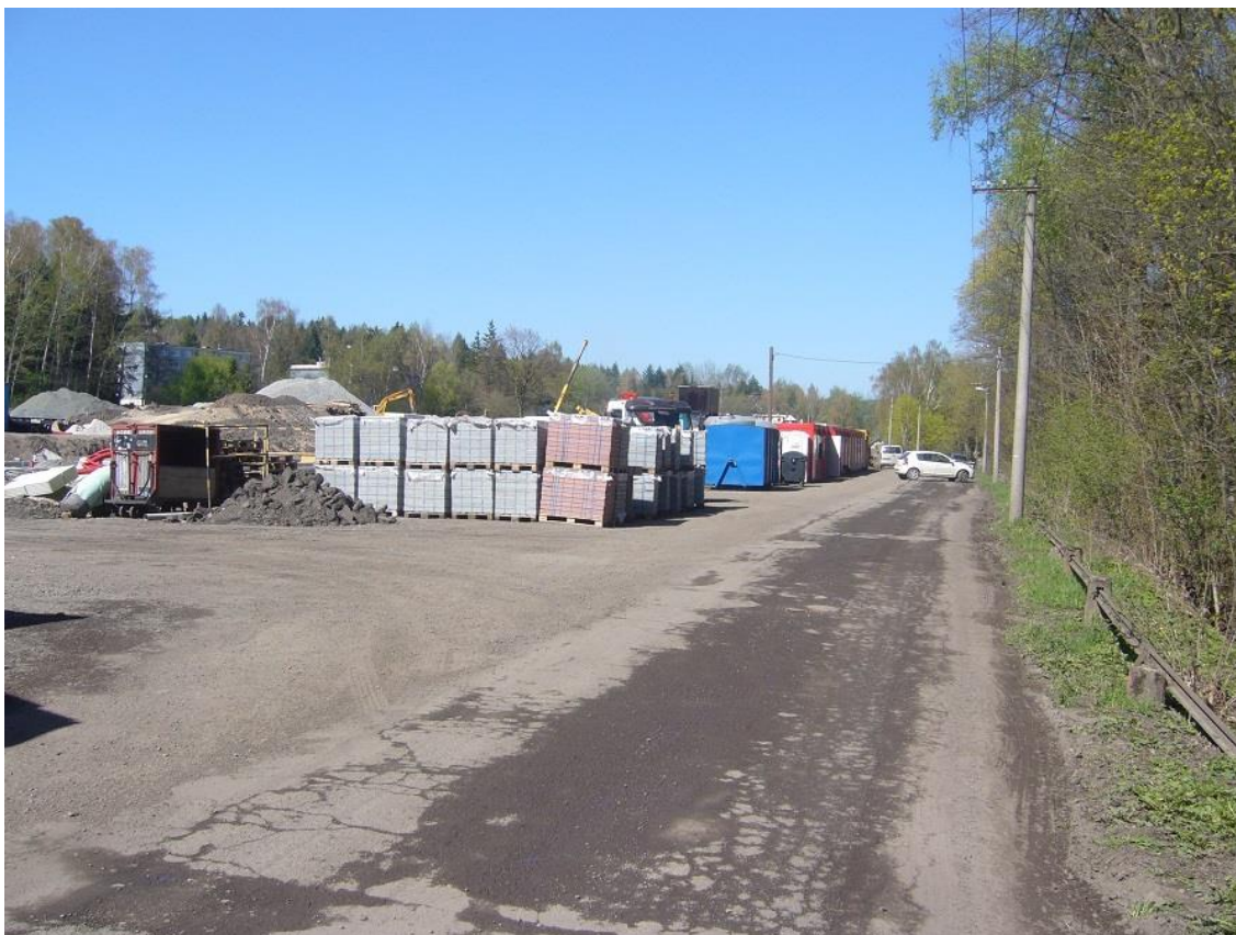
Obrázek F.15: Jeden z dočasných záborů stavebních firem v těsné blízkosti výpravní budovy žst. Mirošov (21. dubna 2016)
