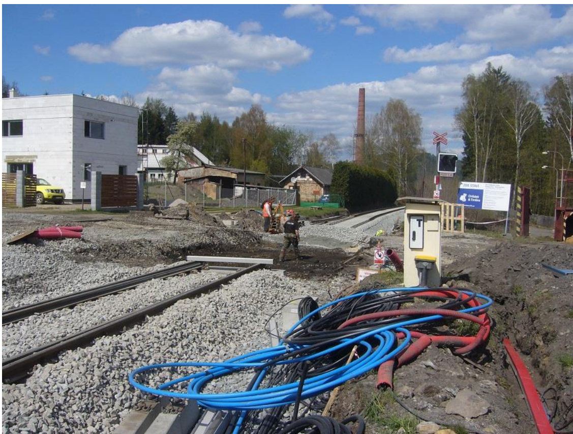
Obrázek F.16: Rekonstrukce přejezdu v Mirošově v Janovské ulici (29. dubna 2016)
