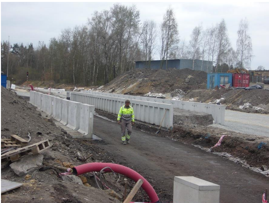
Obrázek F.12: Nová nástupiště v žst. Mirošov v počátcích výstavby (8. dubna 2016)
