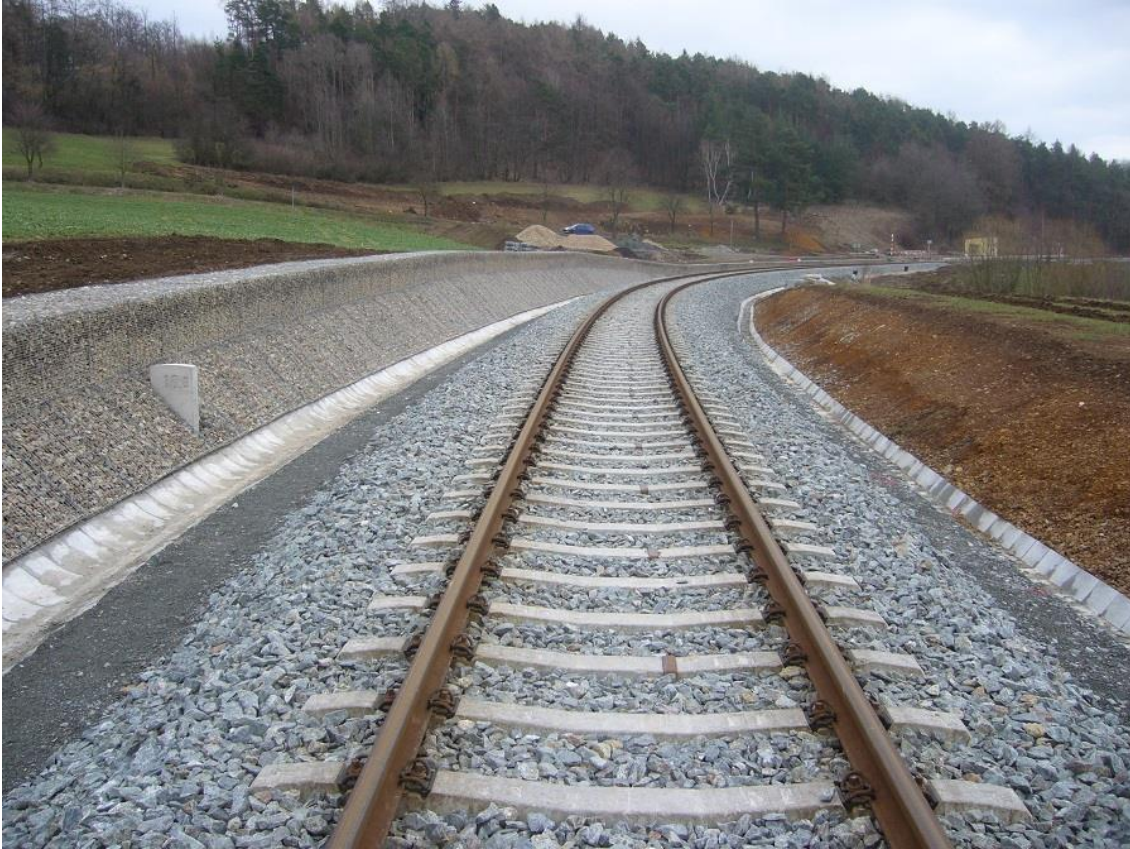
Obrázek F.5: Ochranná gabionová zeď poblíž zast. Příkosice zastávka (26. března 2016)
