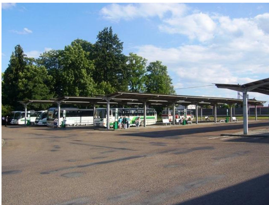
Obrázek 21: Autobusové nádraží v Rokycanech, jeden z nejvýznamnějších dopravních uzlů v regionu. V pozadí protibluková stěna oddělující železniční stanici Rokycany, skrz lze naštěstí projít stezkou pro pěší.
