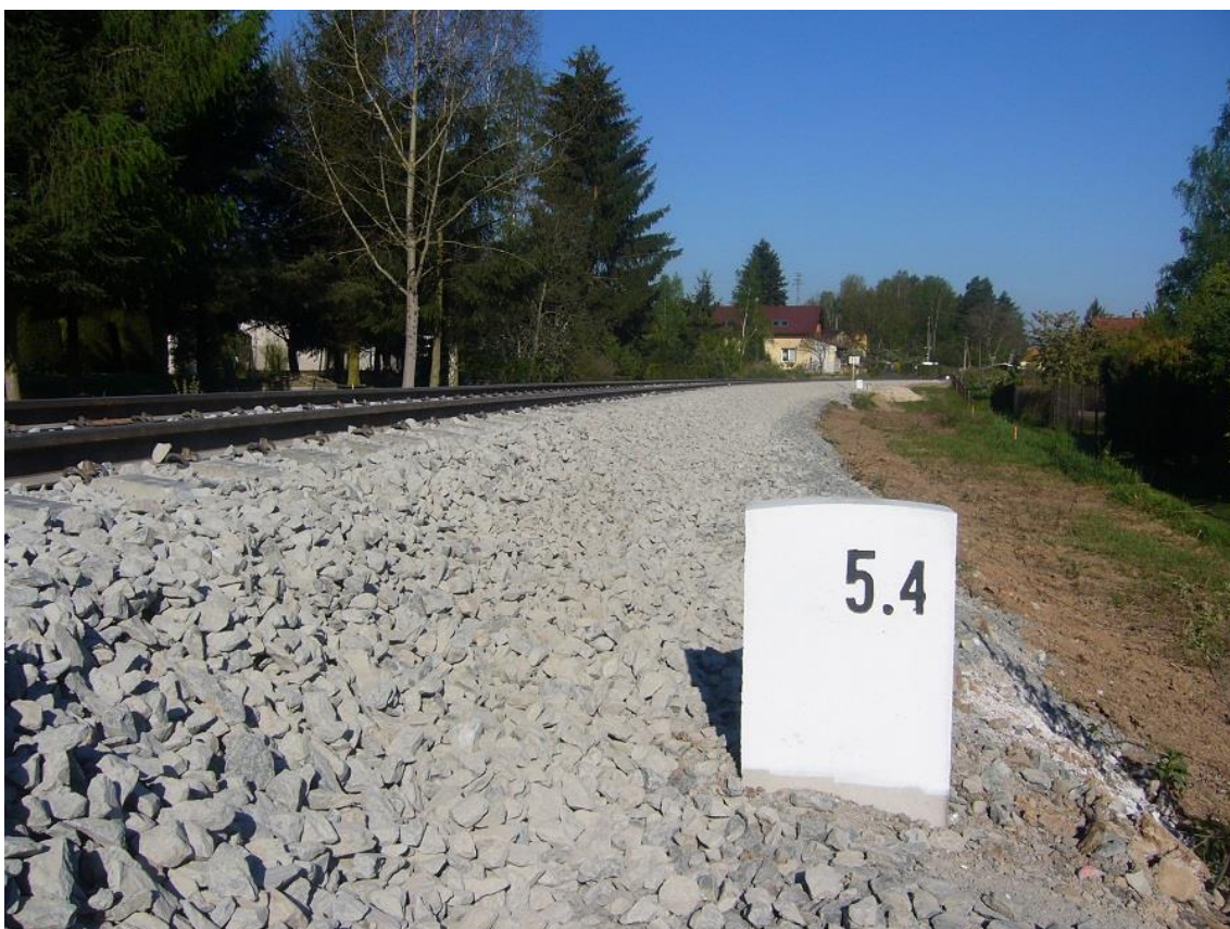
Obrázek F.20: Nový hektometrovník v km 5,4 a revitalizovaná trať (Hrádek u Rokycan, 9. května 2016)
