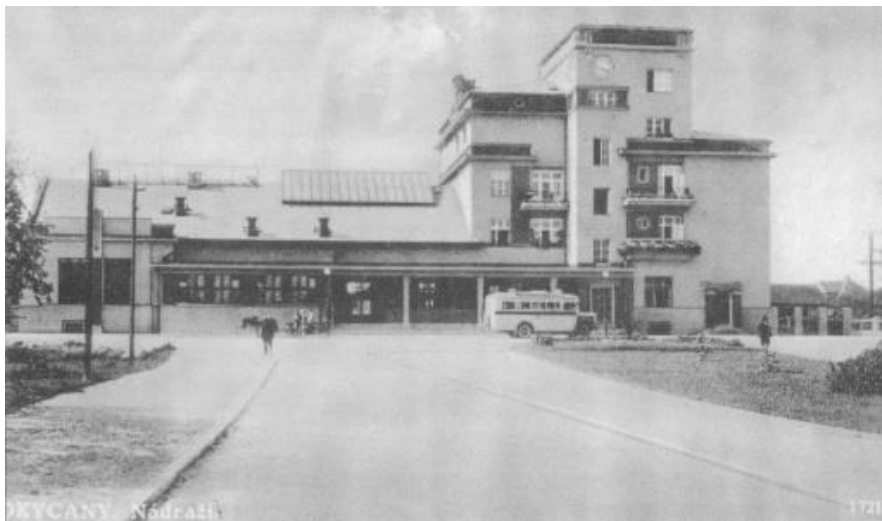
Obrázek 4: Historická fotografie dodnes sloužící výpravní budovy v Rokycanech z doby těsně po jejím dokončení [15]
