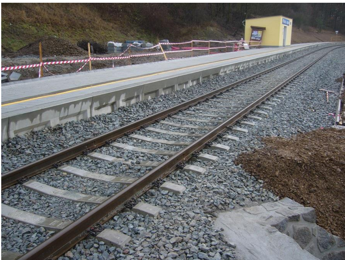
Obrázek F.2: Nové nástupiště v žst. Přikosice zastávka (12. prosince 2015)
