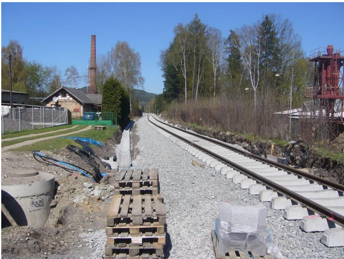
Obrázek F.13: Nový kolejový rošt v obvodu žst. Mirošov směr Hrádek u Rokycan (21. dubna 2016)
