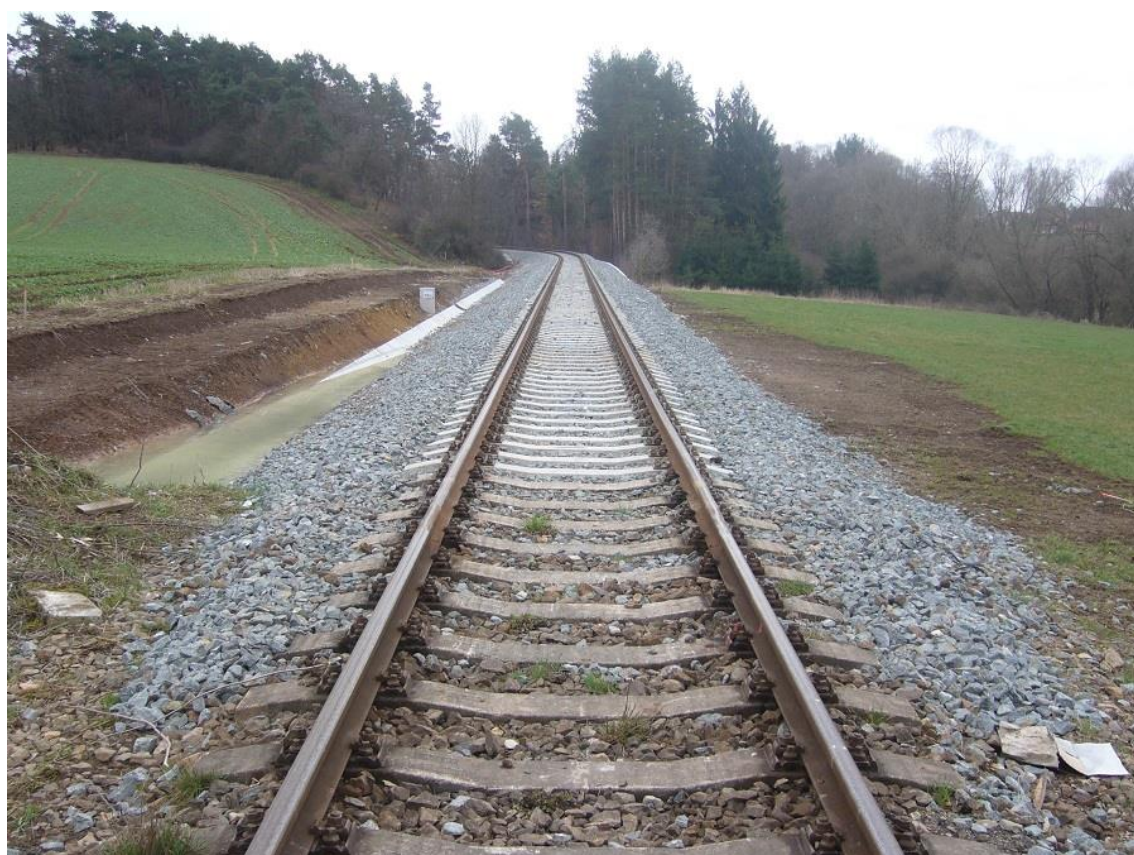
Obrázek F.4: Dočasný přechod mezi revitalizovanou a původní tratí na hranicích katastru Mirošova a Příkosic (26. března 2016)
