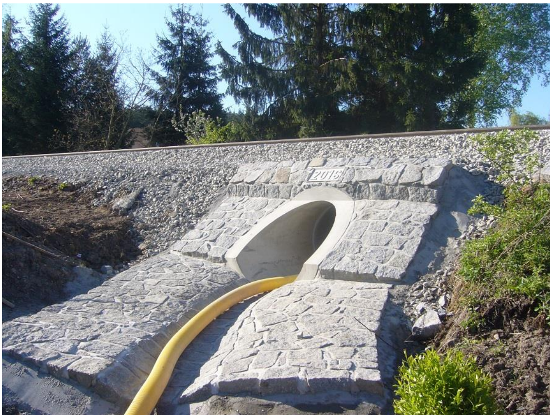
Obrázek F.19: Zrekonstruovaný propustek poblíž zast. Hrádek u Rokycan (9. května 2016)
