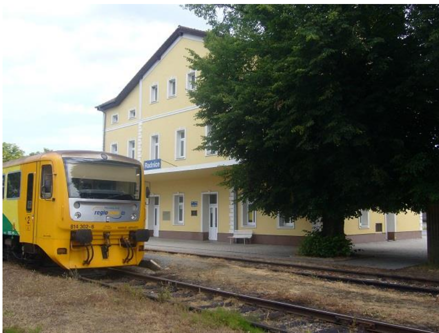
Obrázek 10: Motorová jednotka v popředí zrekonstruované výpravní budovy žst. Radnice
