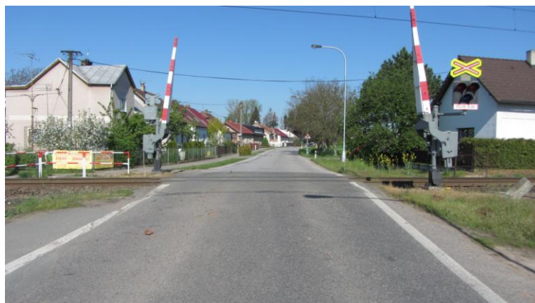
Obr. 15: Železniční přejezd přes trať č. 031 v ulici Předměřická, Hradec Králové, směr západ
