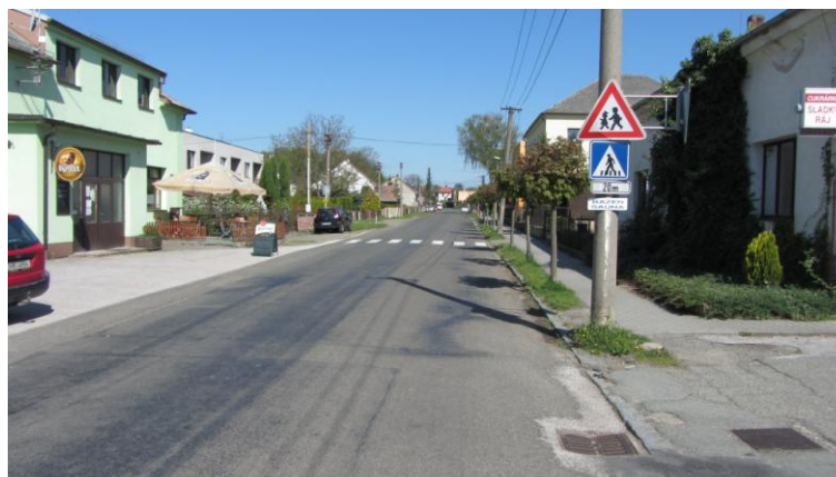
Obr. 49: Hlavní komunikace ve Všeřtarech, směr severozápad
