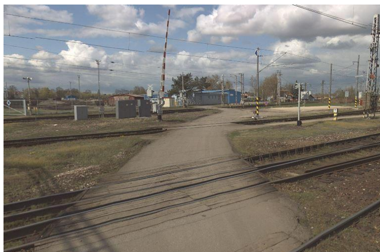
Obr. 13: Železniční přejezdy přes tratě č. 020, 031, 041 v ulici Na Důchodě, Hradec Králové, směr sever (Zdroj: mapy.cz)
