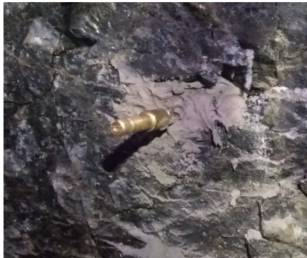
Obr. 7 - Trn pro uchycení signalizačních terčů
