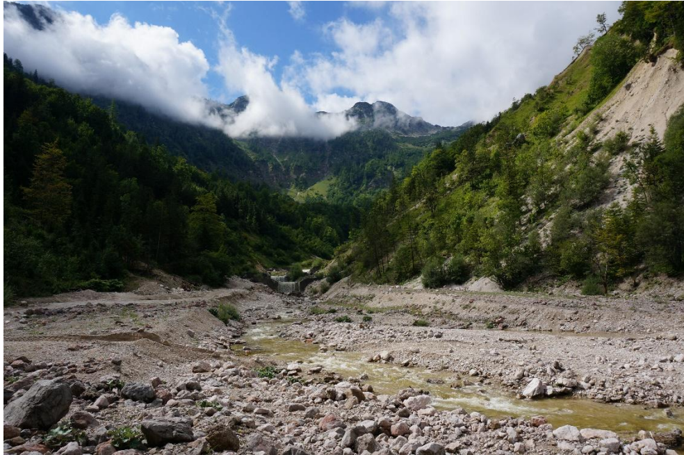
Obrázek 33: Pohled z koruny přehrážky Dümlersperre
