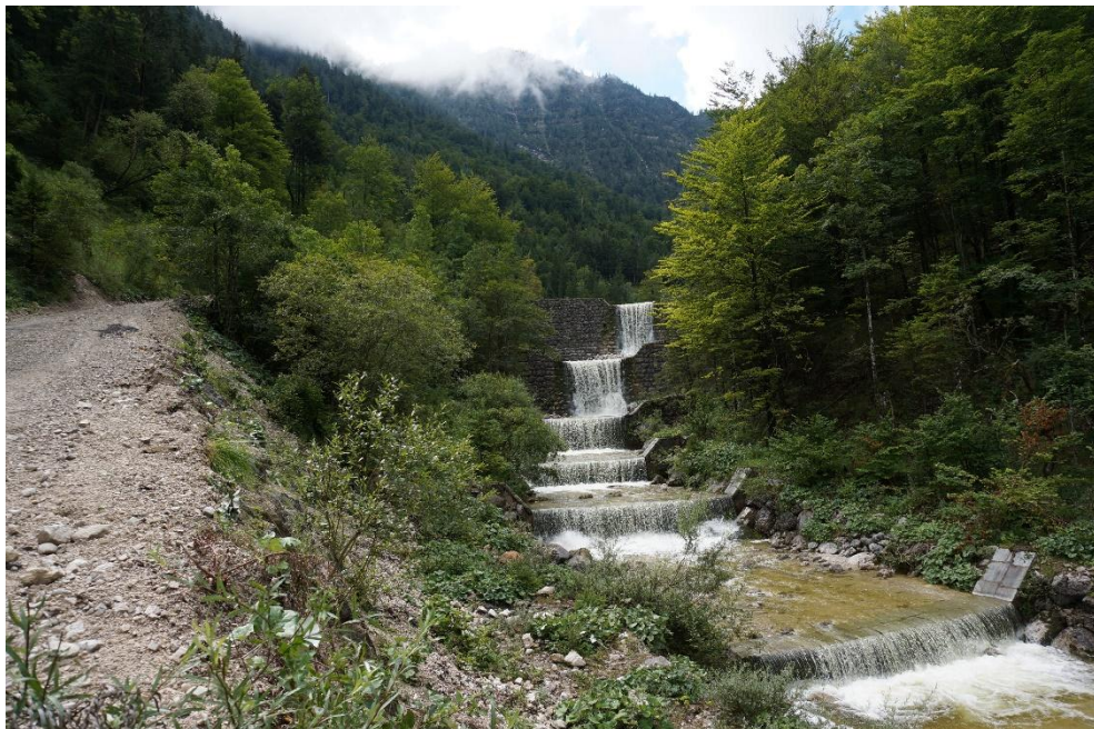
Obrázek 32: Soustava příčných objektů na toku Gimbach
