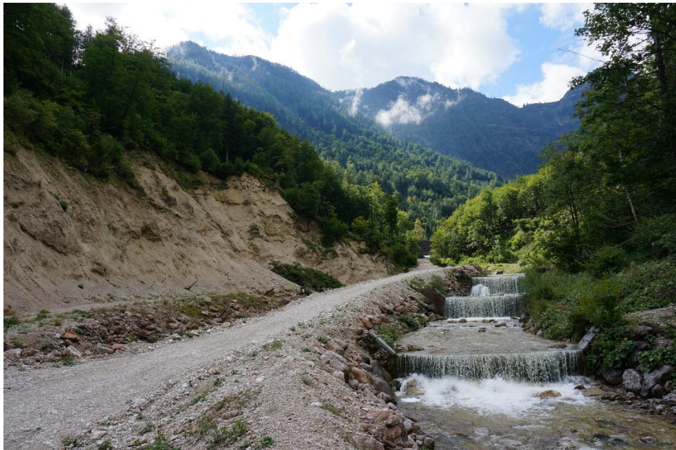
Obrázek 31: Kamenné stupně na toku Gimbach
