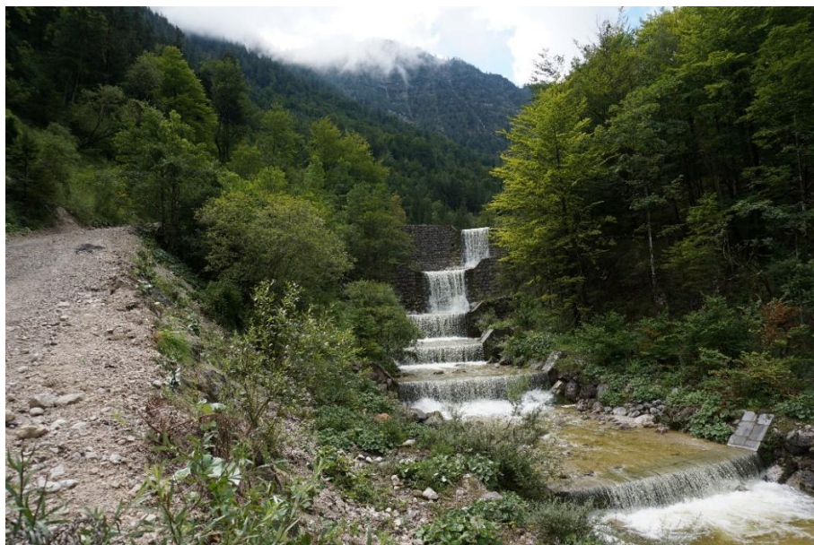
Obrázek 9: Pohled na kaskádu kamenných stupňů a přehrážek
