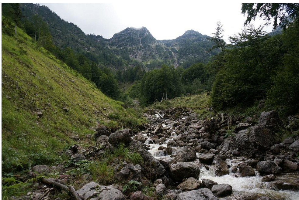
Obrázek 36: Dolní úsek strže Finsterwaldgraben
