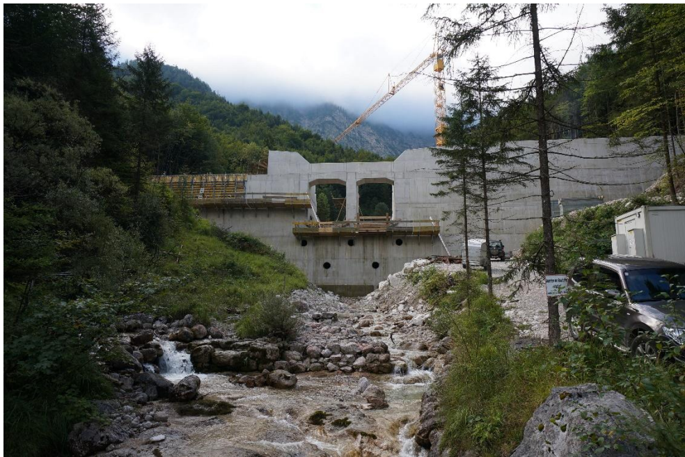
Obrázek 30: Stavba železobetonové přehrážky
