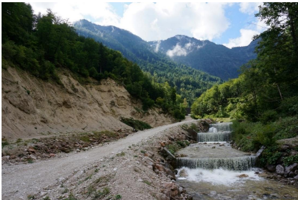
Obrázek 8: Soustava kamenných a betonových přehrážek
