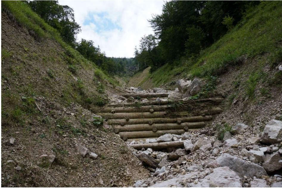
Obrázek 29: Dřevěný srubový stupeň na strži Schüttinggraben
