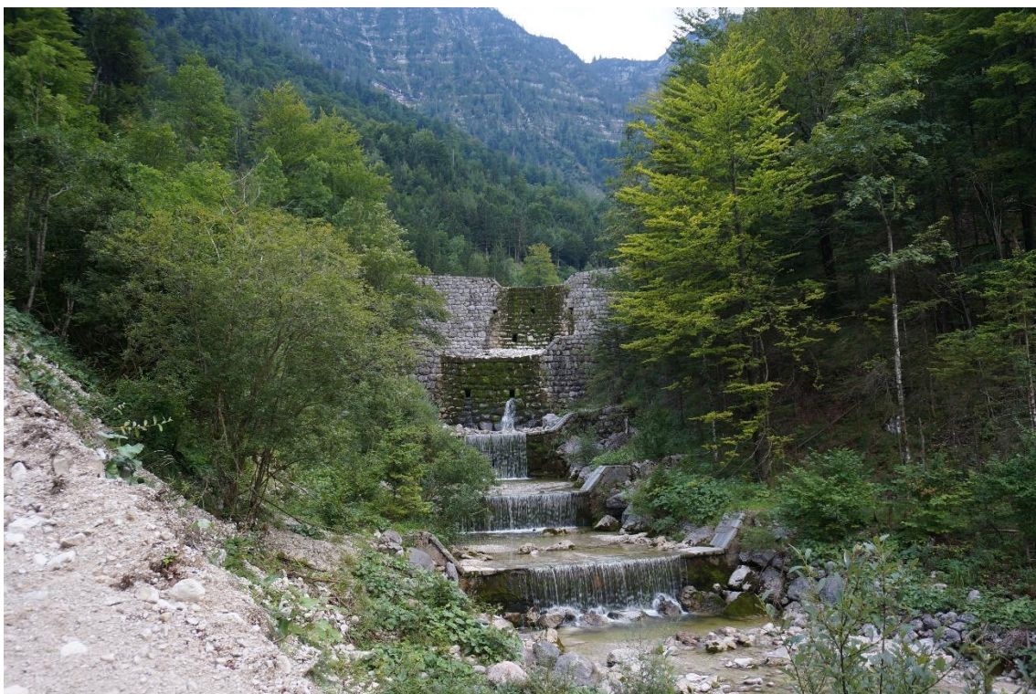
Obr. 7: Historické hrazení na toku Gimbach
