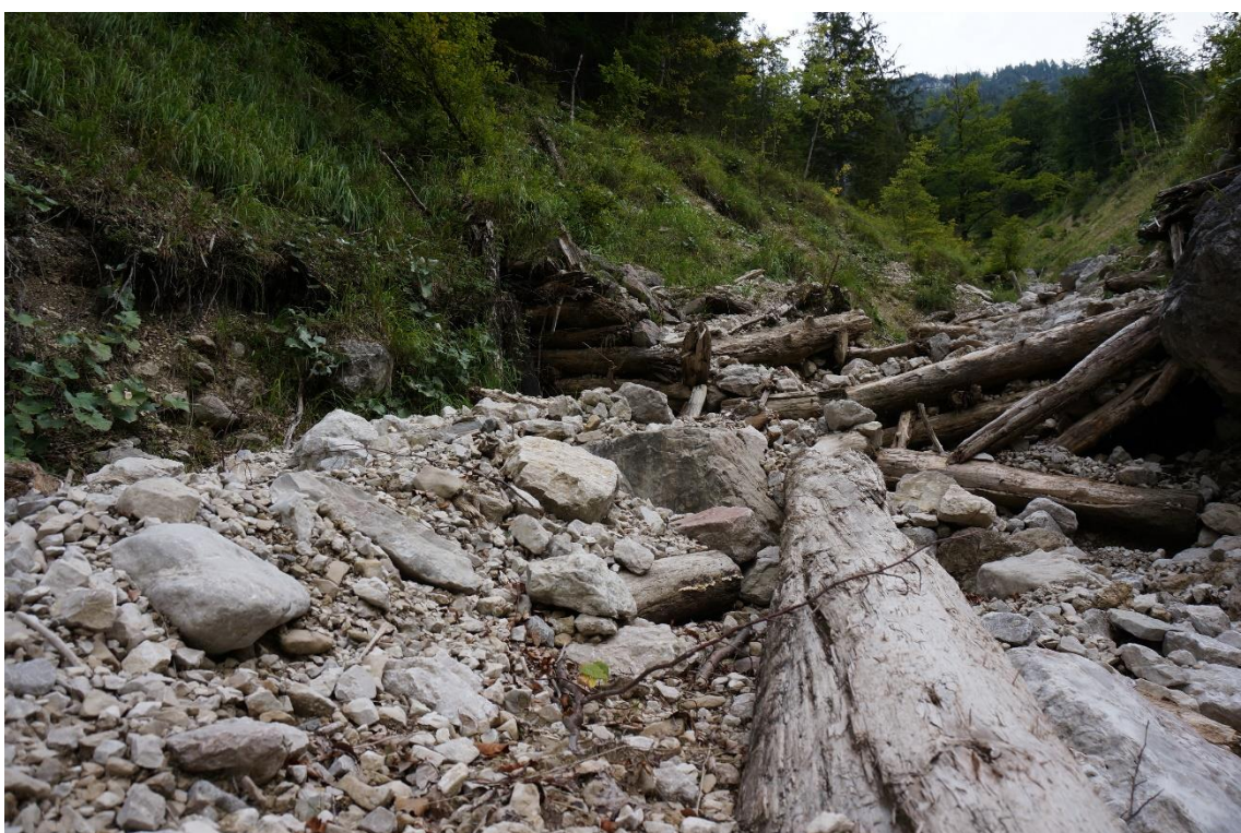
Obr. 9: Poničené dřevěné hrazení – strž Schuttinggraben na povodí Gimbach
