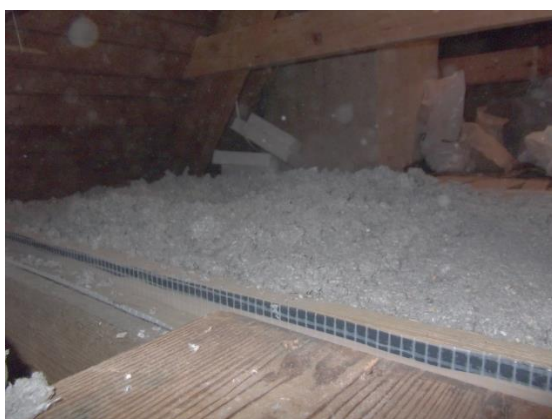
Obrázek 34: „Bedničky“ naplněné před stlačením Zdroj: Autor
