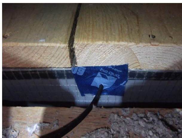
Obrázek 68: Utěsnění prostupu kabelu Zdroj: Autor
