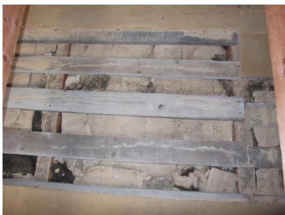
Obrázek 10: Odstranění pochozí vrstvy půdy
