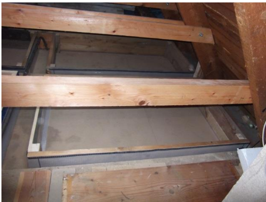
Obrázek 28: Uložení „bedniček“ na půdě 1 Zdroj: Autor
