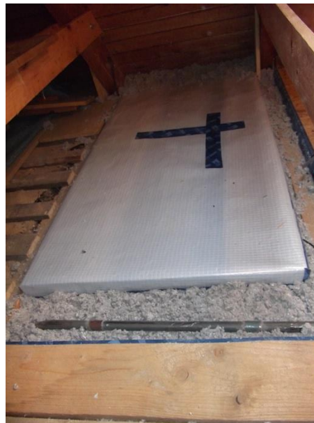
Obrázek 59: Prostor mezi vzorky pro odebrání vzorku varianty bez záklopu Zdroj: Autor
