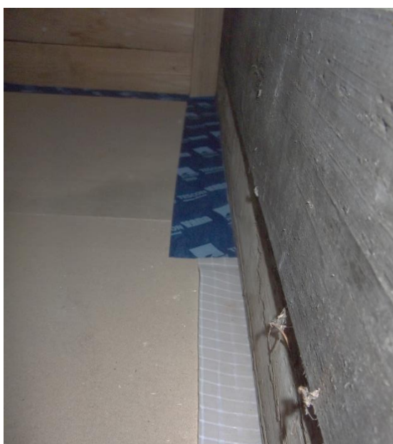
Obrázek 32: Utěsnění vzorku TESCON VANA 3 Zdroj: Autor
