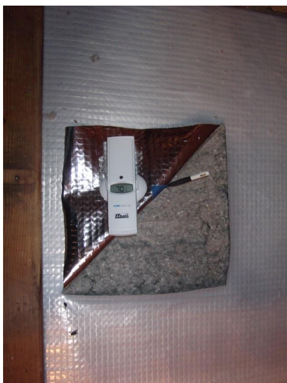
Obrázek 76: Rozříznutí fóliového záklopu Zdroj: Autor
