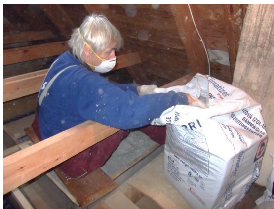
Obrázek 33: Ruční ukládání izolantu Zdroj: Autor
