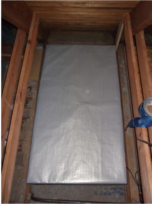
Obrázek 44: Fóliový záklop Zdroj: Autor
