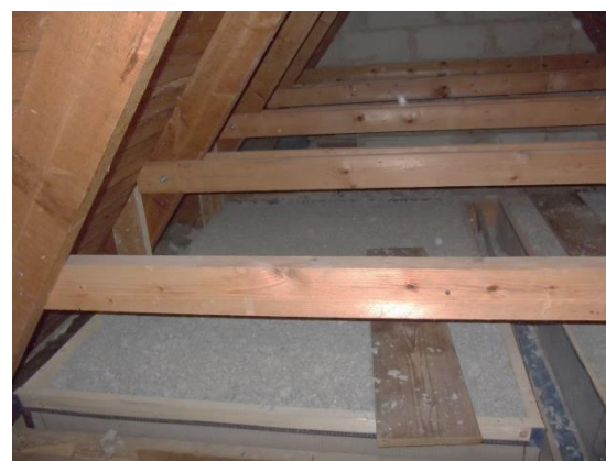
Obrázek 35: Úprava izolantu před zaklopením Zdroj: Autor
