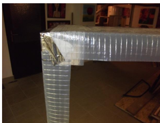
Obrázek 27: Dotěsnění hřebíků Zdroj: Autor
