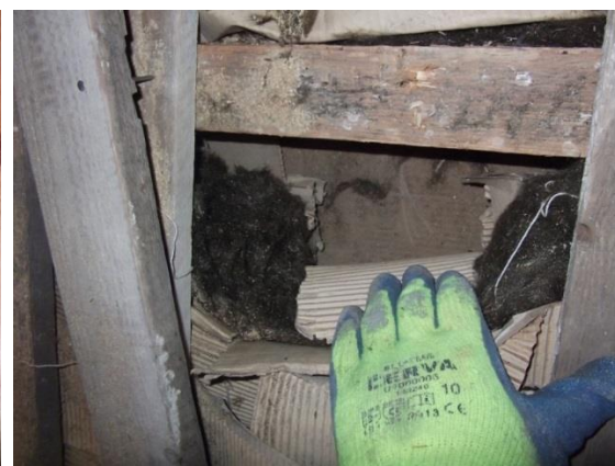
Obrázek 11: Průhled skladbou stropu
