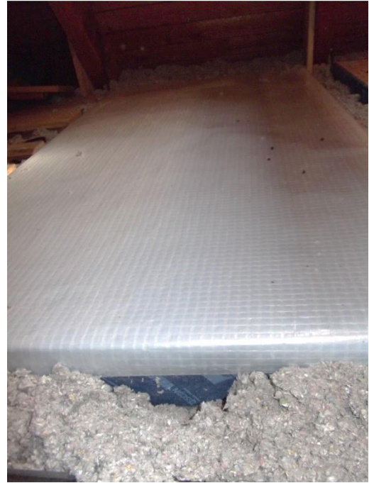
Obrázek 45: Utěsnění fóliového záklopu Zdroj: Autor
