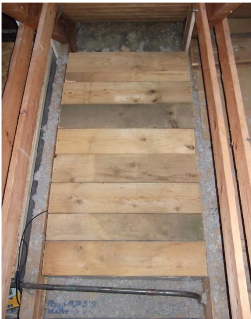
Obrázek 40: Kompletní prkenný záklop Zdroj: Autor
