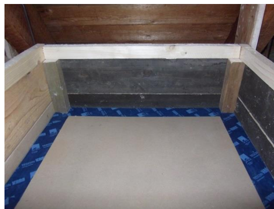
Obrázek 31: Utěsnění vzorku TESCON VANA 2 Zdroj: Autor
