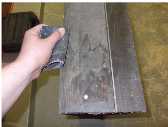
Obrázek 22: Vyhlazení povrchu pod lepicí páskou Zdroj: Autor
