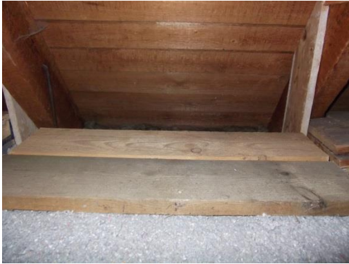
Obrázek 38: Prkenný záklop Zdroj: Autor
