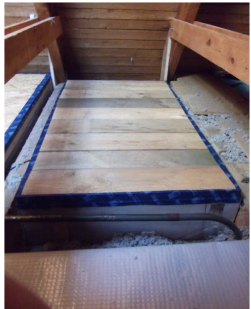
Obrázek 41: Utěsnění prkenného záklopu Zdroj: Autor
