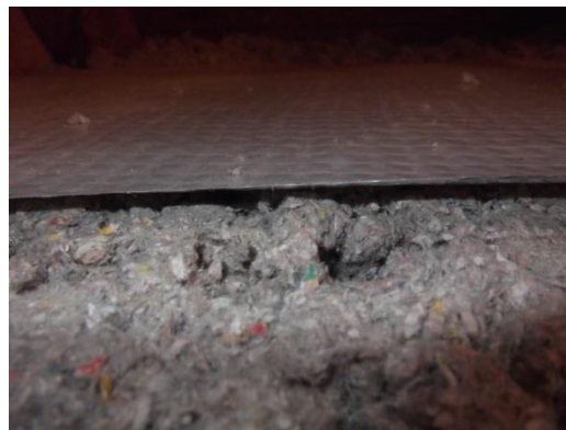
Obrázek 46: Utěsnění fóliového záklopu Zdroj: Autor
