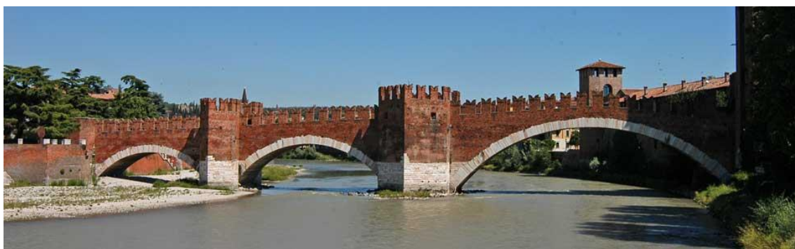
Obr. 1.8 - Ponte di Castelvecchio (Verona) [viii]
