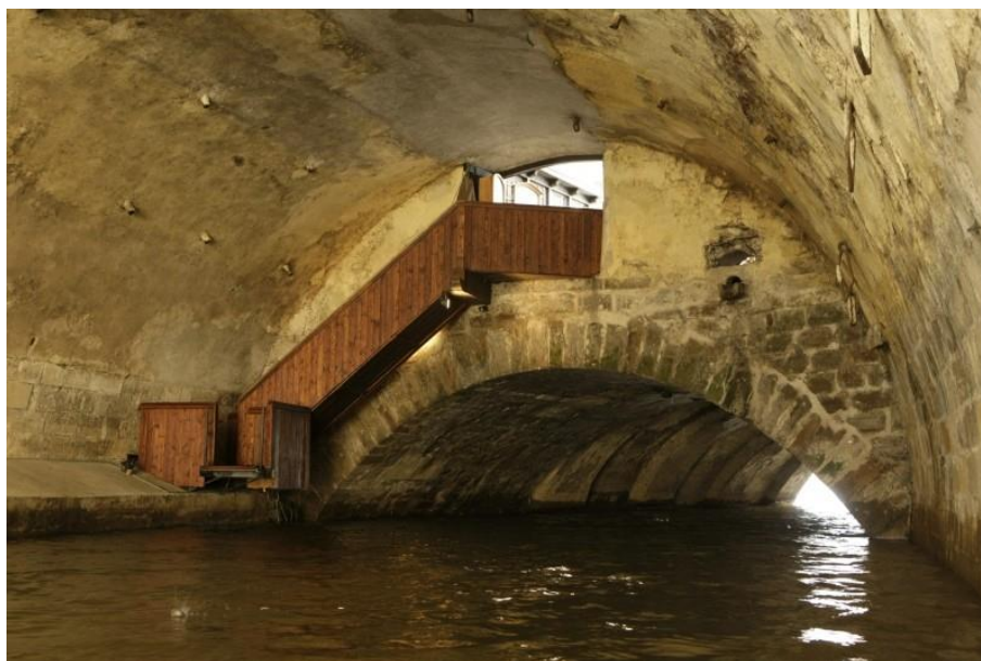
Obr. 1. 14 - Původní mostní oblouk Juditina mostu v blízkosti křížovnického areálu [xiv]
