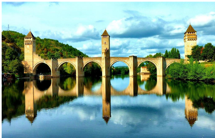
Obr. 1.7 - Pont Valentré [vii]
