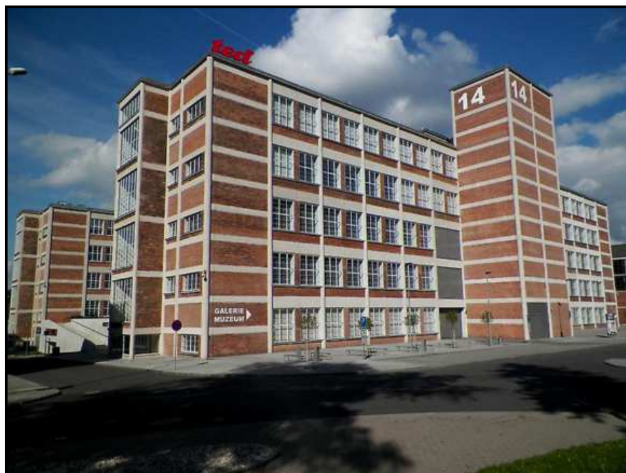
Obrázek 8 – Budova č. 14 areálu Zlínských Baťových závodů (zdroj: internet)
