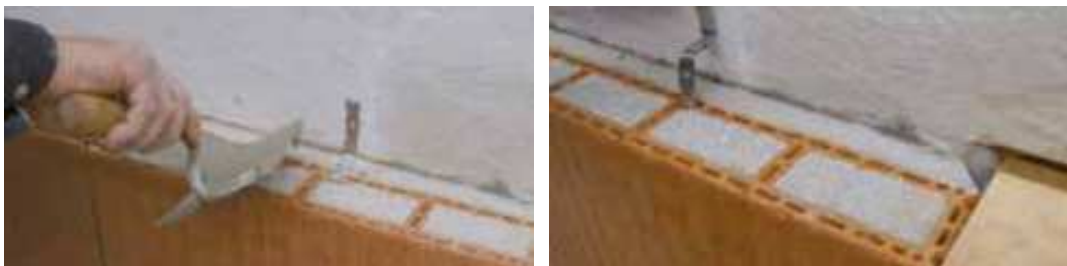
Obrázek 47 – Ukázka realizace keramické přizdívky (zdroj: produktový list)
