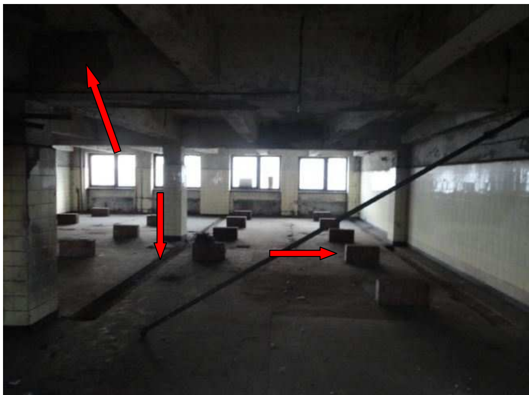
Obrázek 31- Stávající šatny 3.np (zdroj: vlastní)
