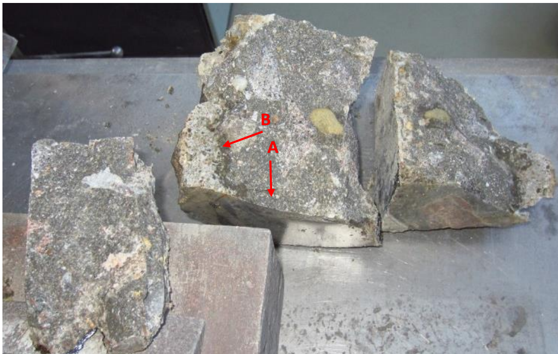
Obrázek 35: Vzorek části betonové konstrukce z objektu RS-73 (foto autorka 11. 4. 2014)
