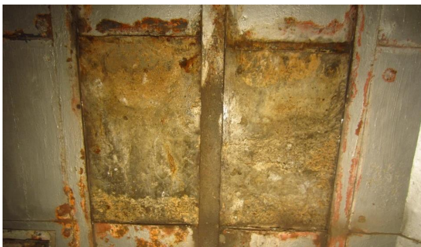
Obrázek 83: Odhalená stěna v místě vápenného výkvětu (foto autorka 4. 8. 2015)
