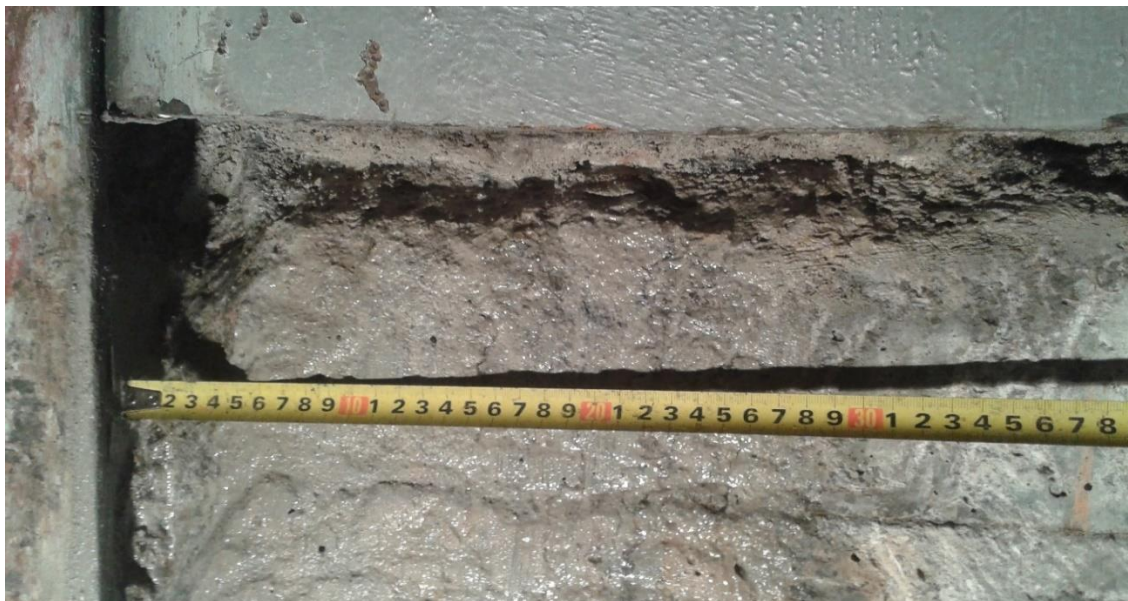
Obrázek 85: Místo kudy voda proniká do interiéru v největším množství (foto autorka 4. 8. 2015)
