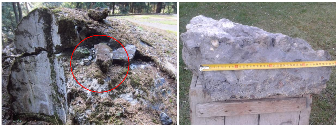
Obrázek 33: Vzorek betonu z konstrukce střechy na místě odběru (foto a. 29. 3. 2014)
