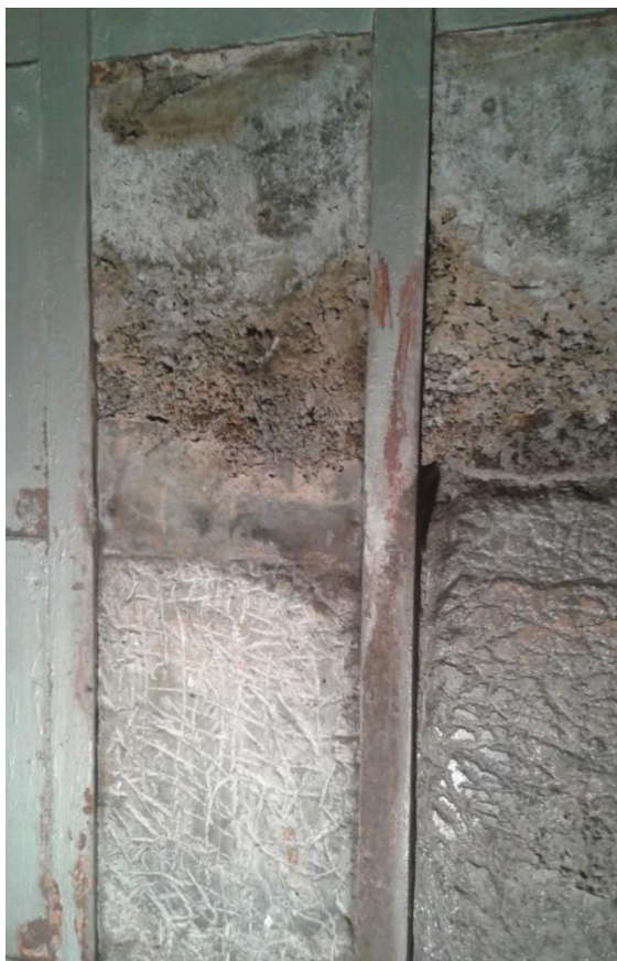
Obrázek 86: Odhalená stěna, spodní část je již zdrsňena pro aplikaci nátěru (foto autorka 4. 8. 2015)
