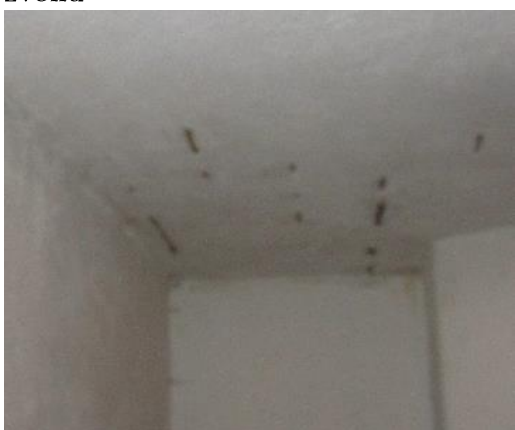
Obrázek 23: Obnažená výztuž, střel. místnost
