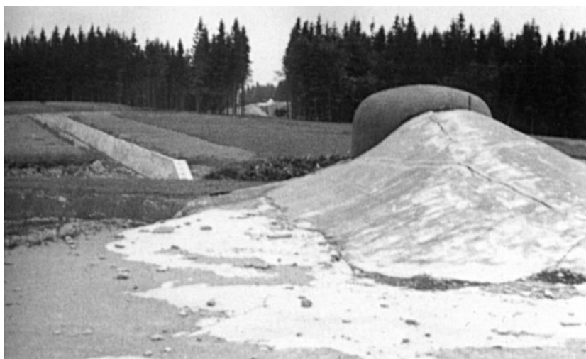
Obrázek 12:, její Degradace nabetonávky na asf. pásech 1960 (archiv Jana Škody)
