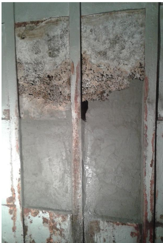
Obrázek 87: Krystalizační nátěr aplikovaný na sanovanou stěnu (foto autorka 5. 8. 2015)
