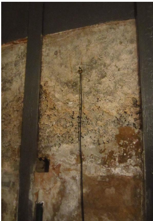
Obrázek 69: Teplotní sonda pro záznam povrchové teploty a vlhkosti (foto autorka 10. 3. 2016).
