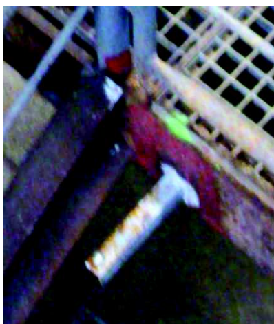
Obr. 8: Ocelová čepová mini značka bodu v konstrukci schodiště [vlastní fotografie]
