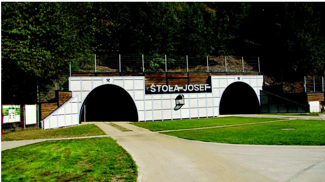
Obr. 2: Vstupní portály štoly Josef [2]
