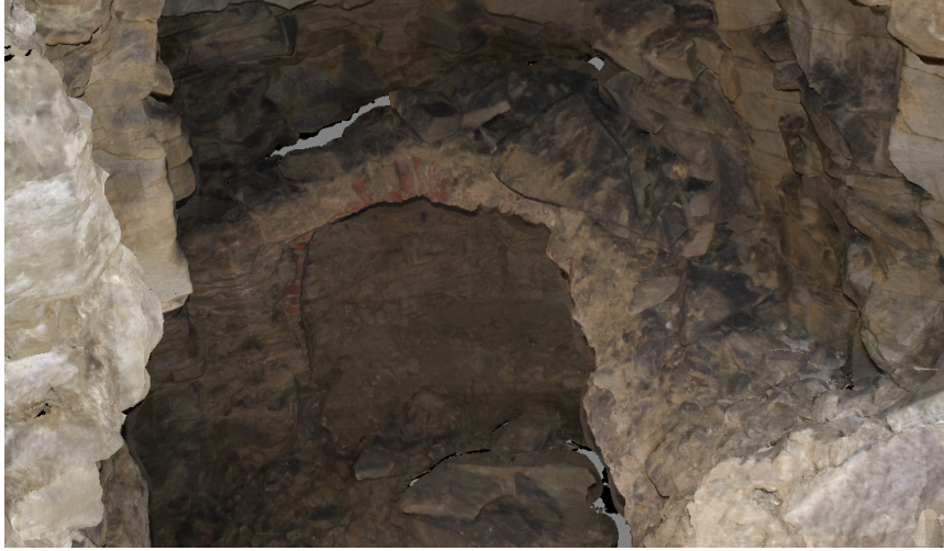
Obrázek 35: 3D model pravého traktu se spadáným stropem. [Agisoft Photoscan]
