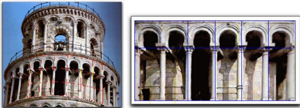
Obr. 10: Příklad rozvinutí pomocí geometrie v softwaru DigiCAD 3D
