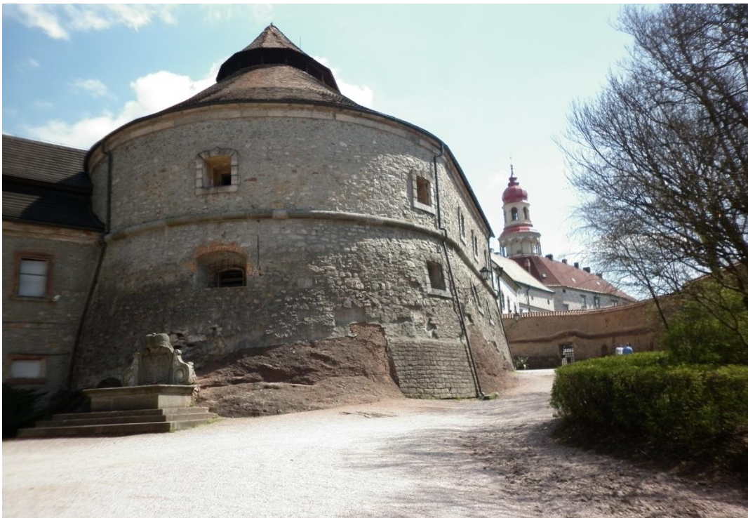
II.a - 13b: V. nádvoří, pohled od dolní brány na turion s kašnou - současnost, GPS souřadnice: 50°25'09.7''N, 16°09'37.7''E (foto: autor )
