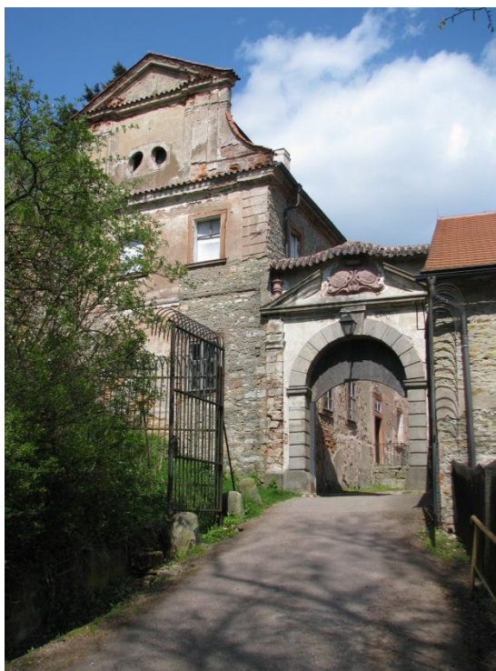
II.a - 16b: Štít úřednického traktu a brána do V. nádvoří se znaky Piccolominy - Kolovratskými - současnost, GPS souřadnice: 50°25'08.6''N, 16°09'36.5''E (foto: autor )
