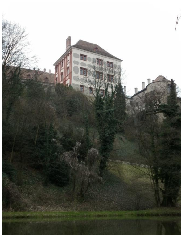
I.a - 2b: Pohled z údolí Zlatého potoka na renesanční trakt se studniční věží - současnost, GPS souřadnice: 50°15'52.6''N, 16°07'01.8''E (foto: autor )
