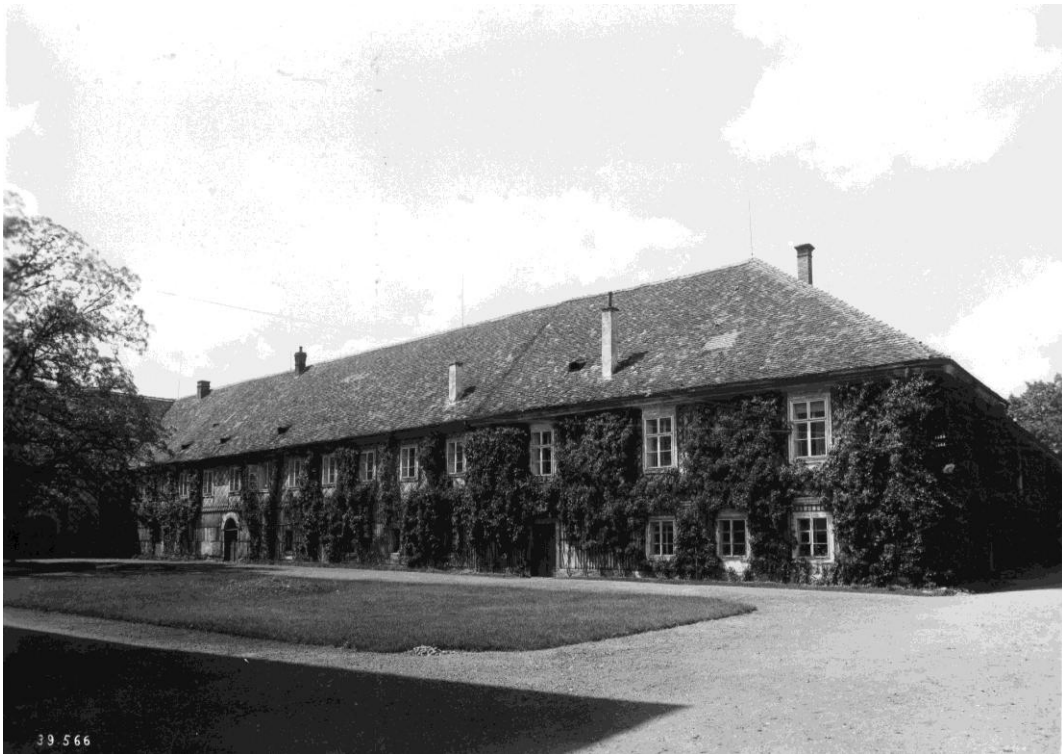
I.a - 11a: Předdvůří, část hospodářské budovy s jízárnou - rok 1948 (zdroj: Fotoarchiv GŘ NPÚ , inv. č. N039.566)
