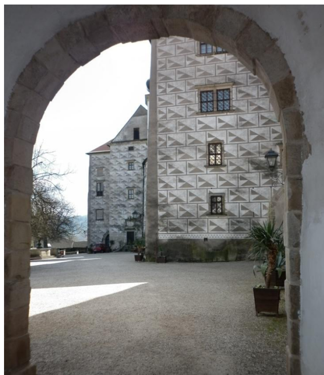
II.a - 8b: Pohled od severu na I. nádvoří - současnost, GPS souřadnice: 50°25'08.5''N, 16°09'40.8''E (foto: autor )
