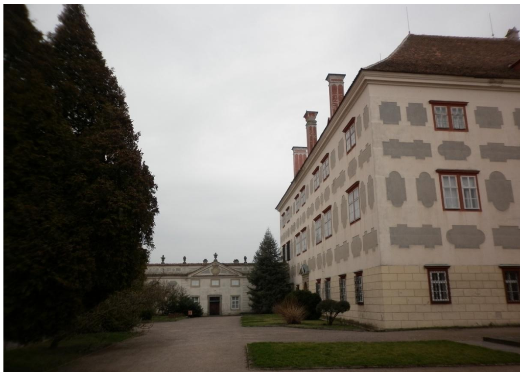
I.a - 7b: Předdvůří, severozápadní část zámku s budovou důchodu - současnost, GPS souřadnice: 50°15'55.3''N, 16°06'53.9''E (foto: autor )
