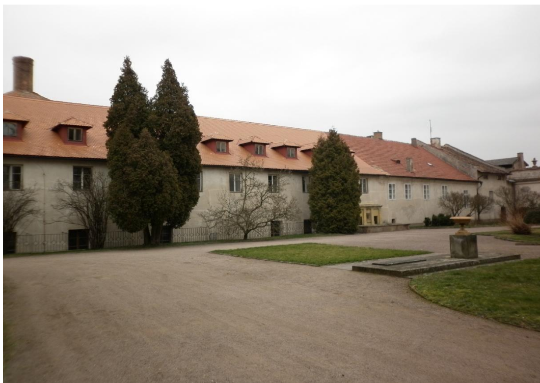
I.a - 9b: Předdvorí, část zámeckého pivovaru - současnost, GPS souřadnice: 50°15'54.7''N, 16°06'54.2''E (foto: autor )
