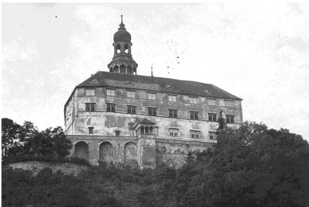
II.a - 1a: Celkový pohled na zámecký objekt od jihu - rok 1910 (zdroj: Fotoarchiv GŘ NPÚ , inv. č. F9.366 )
