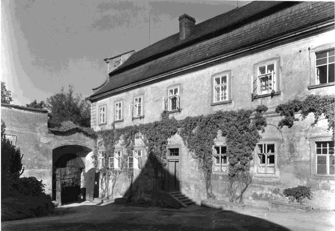
II.a - 15a: V. nádvoří, severozápadní křídlo úřednického traktu - rok 1951 (zdroj: Fotoarchiv GR NPÚ, inv. č. N49.216 )
