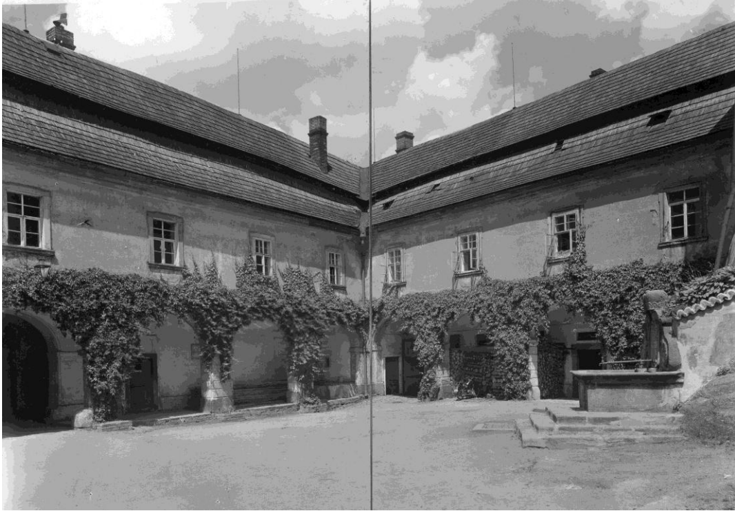
II.a - 14a: V. nádvoří, severní a východní křídlo úřednického traktu s přízemními arkádami - rok 1951 (zdroj: Fotoarchiv GŘ NPÚ , inv. č. N49.218)
