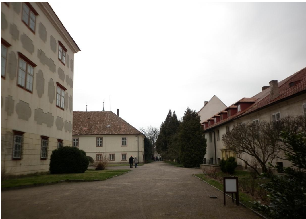
I.a - 10b: Předdvorí, pohled k výjezdu ze zámku, na pravé straně část zámeckého pivovaru, na levé straně severní stěna zámku - současnost, GPS souřadnice: 50°15'55.0''N, 16°06'56.8''E (foto: autor )
