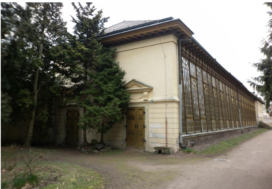
I.a - 14b: Palmový skleník v zámeckém parku, pohled od jihozápadu - současnost, GPS souřadnice: 50°16'01,7''N, 16°06'44.2''E (foto: autor)
