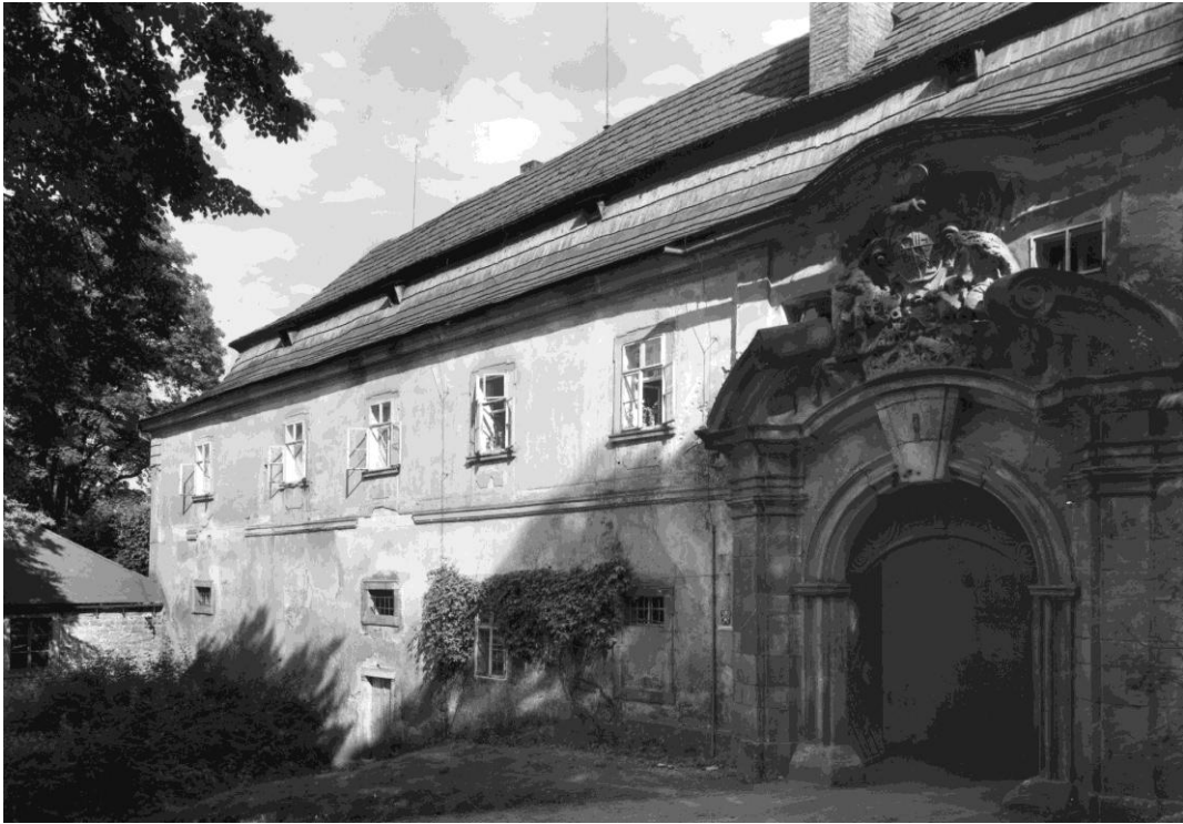
II.a - 17a: Pohled z aleje na část úřednického traktu a vstupní bránu do V. nádvoří se znakem Piccolominským - rok 1951 (zdroj: Fotoarchiv GR NPÚ , inv. č. N49.220)
