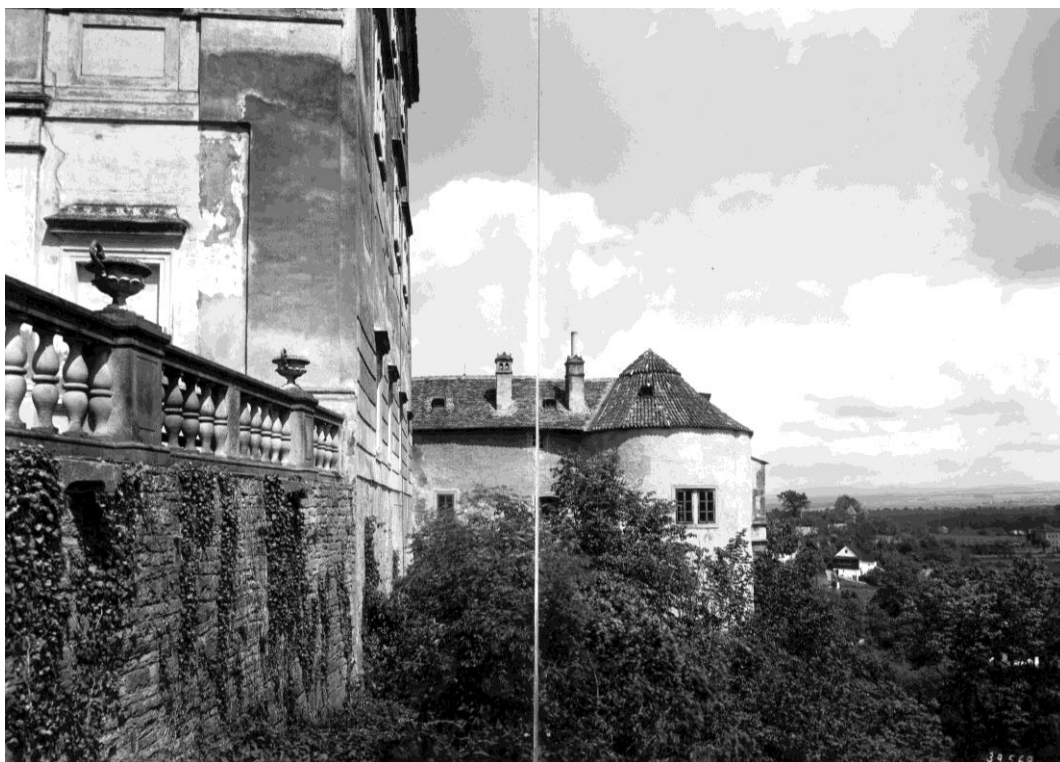
I.a - 5a: Pohled z terasy na studniční věž - rok 1948 (zdroj: Fotoarchiv GŘ NPÚ , inv. č. N039.569)
