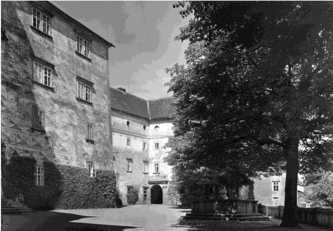
II.a - 5a: I. nádvoří, Piccolominské křídlo na severní straně velkého dvora - rok 1951 (zdroj: Fotoarchiv GŘ NPÚ , inv. č. N49.232)
