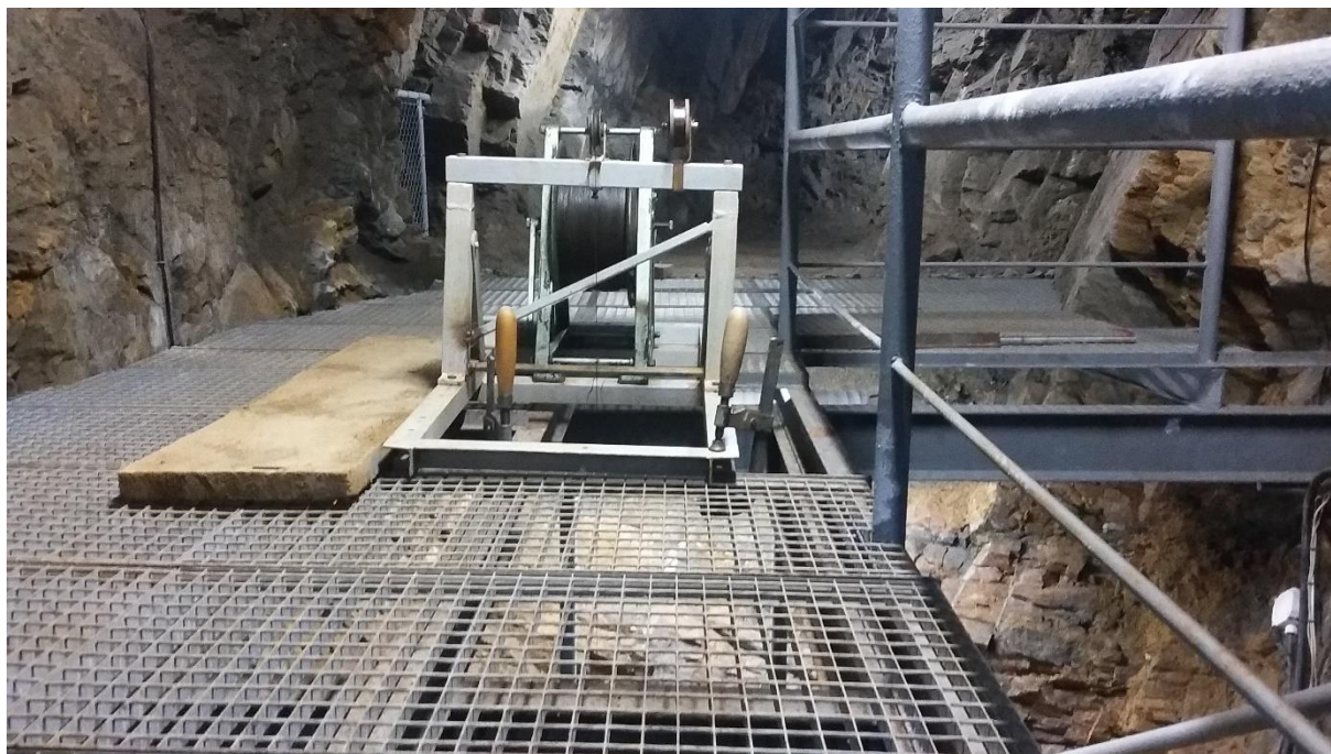
Obr. 10: Konstrukce pro uchycení důlní olovnice
