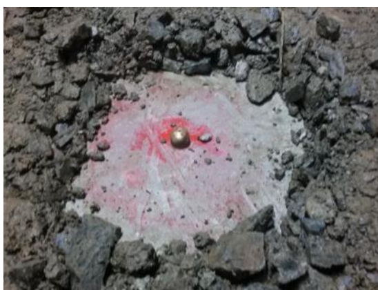
Obr. 6: Stabilizace bodu v počvě
