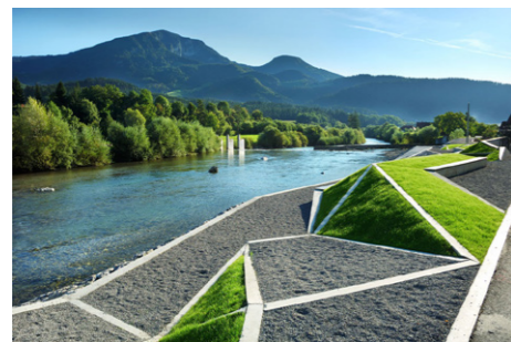
úprava nábřeží General Maister Park, Bruto Landscape Architecture
