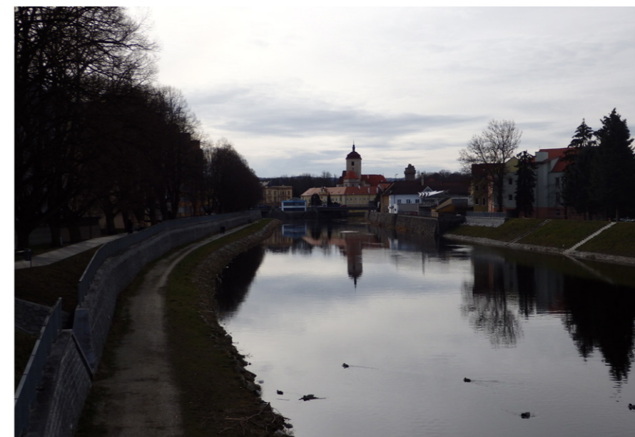
4. OSOVÝ PRŮHLED Z MOSTU V ELLEROVĚ ULICI
