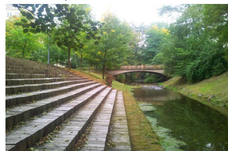
přístup k řece revitalizace břehů říčky Loučná, Litomyšl, J. Pleskot
