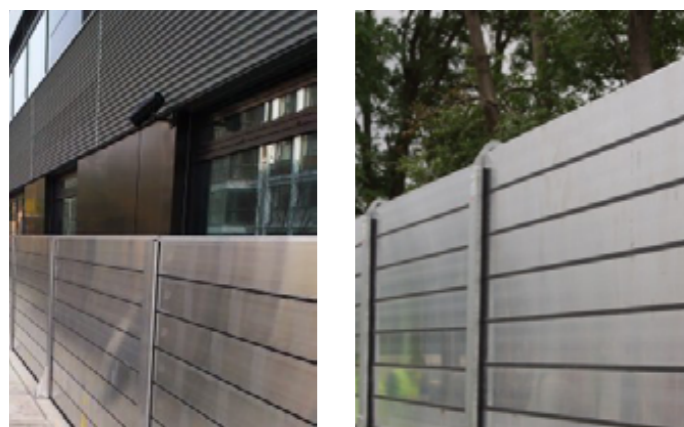
sloupky, M15 sloupky na montáž protipovodňové zdi
